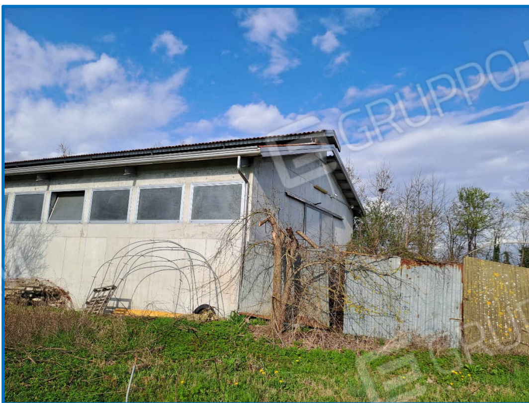
n° 2 Esterno capannone sud-ovest
