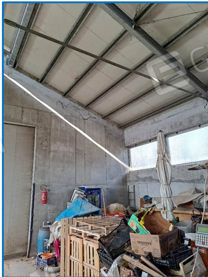
n° 6 - Interno capannone
