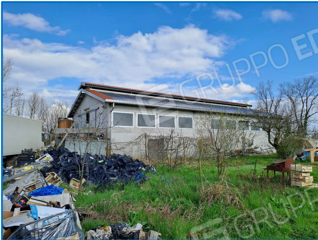
n° 1 – Esterno capannone nord-ovest
