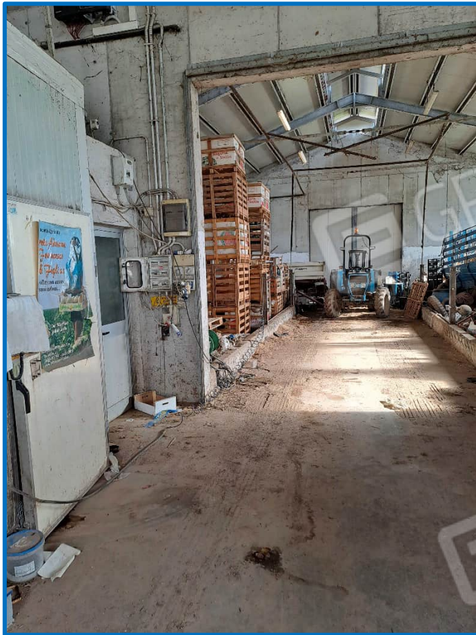
n° 5 Interno capannone
