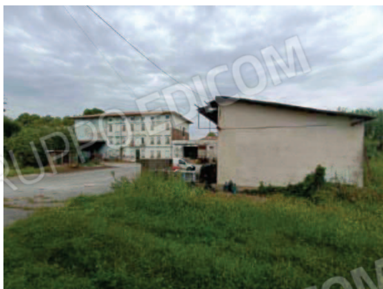
F38: Lotto1 – magazzino nord prospetto est
