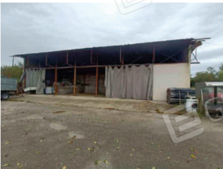
F37: Lotto1 – magazzino nord prospetto sud
