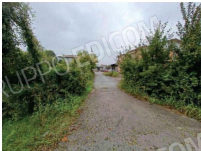
F44: Lotto1 – viabilità interna
