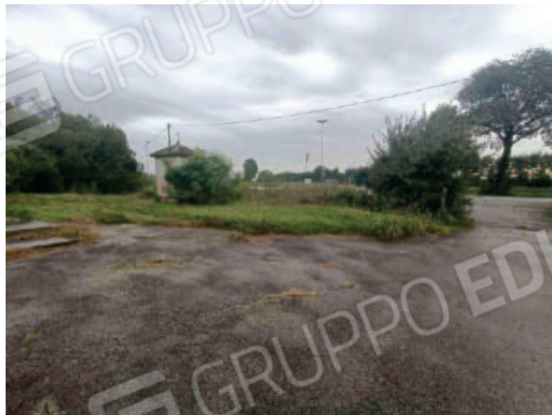
F80: Lotto 2 – zona accesso da viabilità interna
