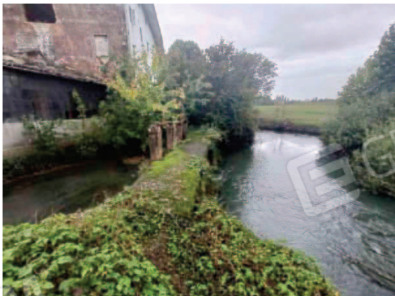
F87: Lotto 3 – passerella opera di presa
