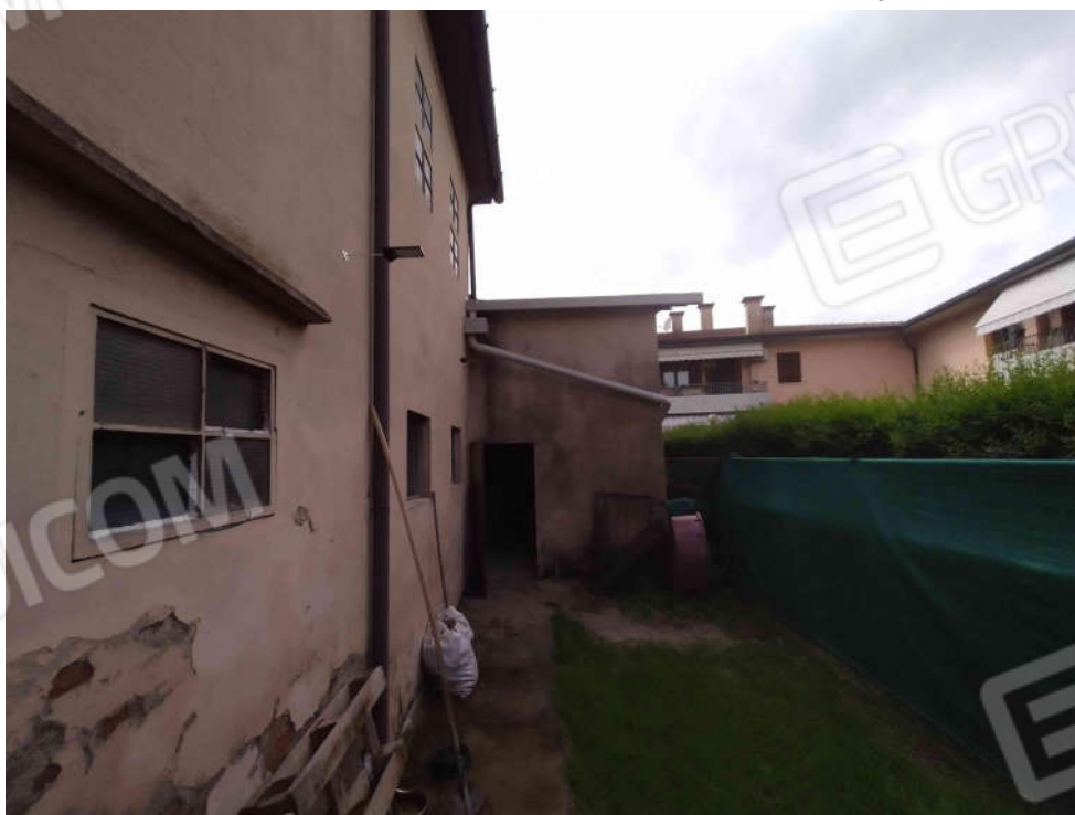
8. esterno a Nord
