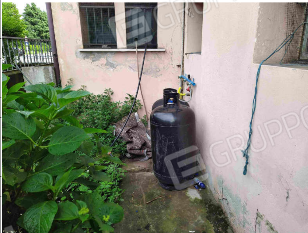
9. esterno a Nord , alimentazione caldaia.
