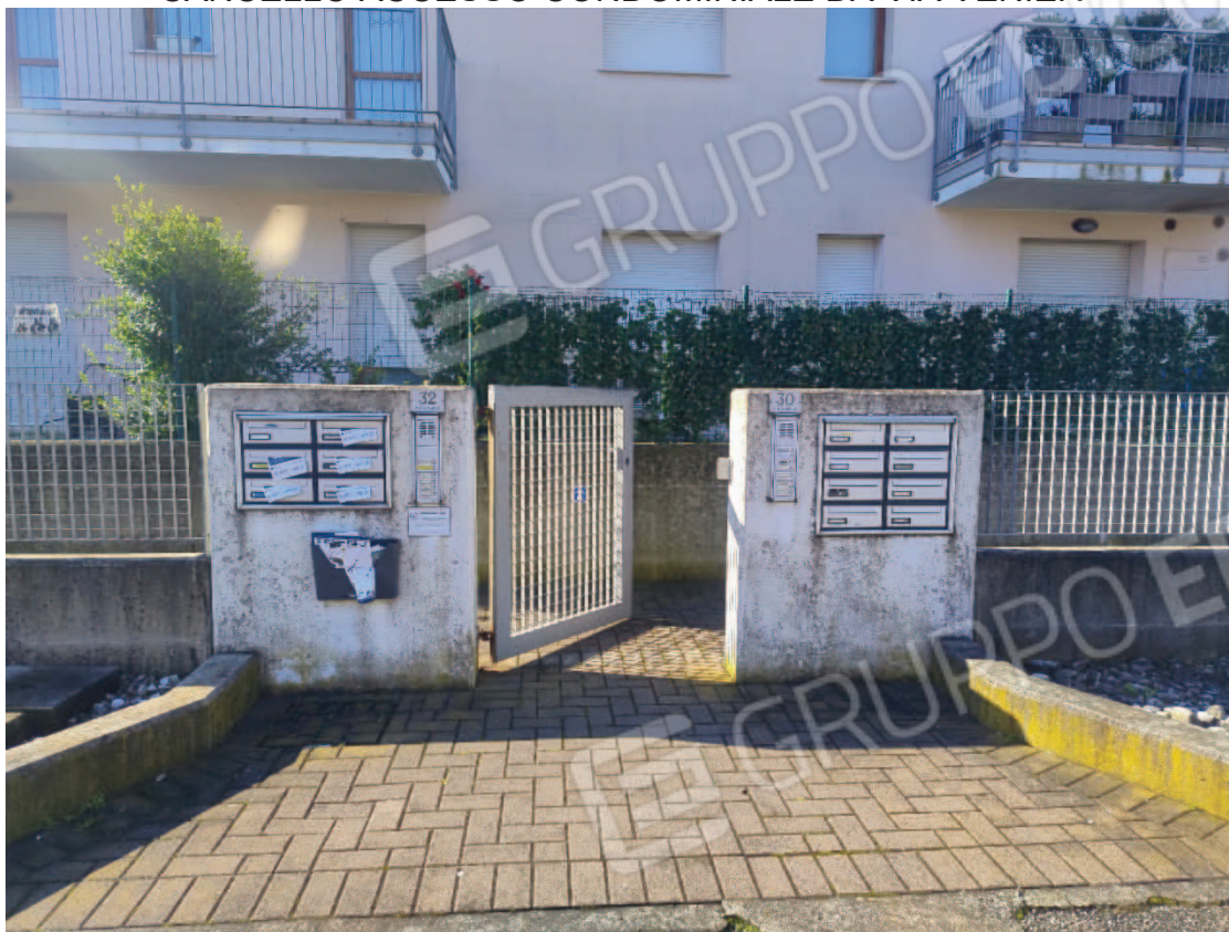
CANCELLO ACCESSO CONDOMINIALE DA VIA VENIER
