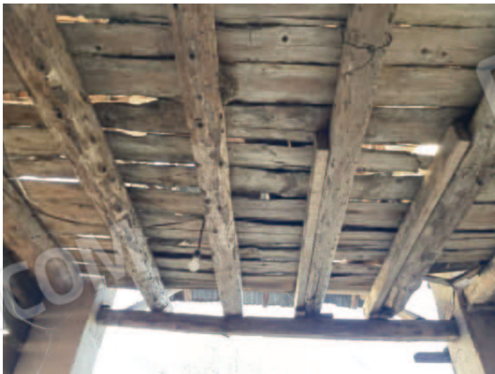
foto n. 9 – solaio locale di accesso
