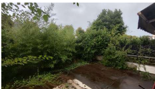
FOTO 15: vista lastrico solare e scoperto
