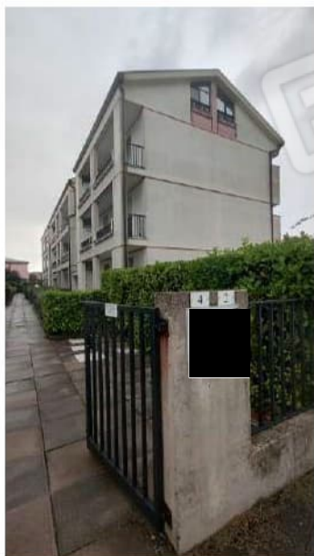
FOTO 1: vista accesso pedonale
