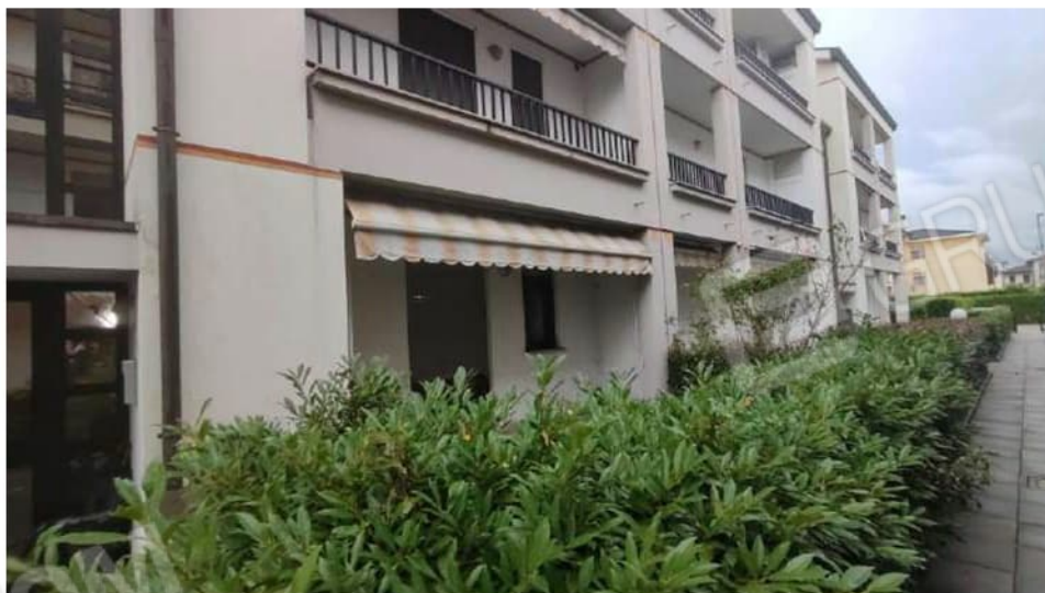
FOTO 3: vista prospetto nord
