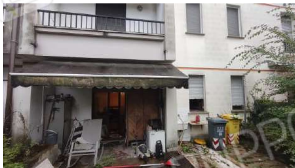
FOTO 14: vista prospetto sud
