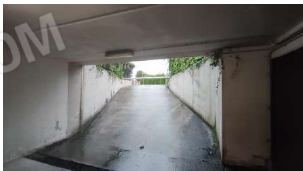
FOTO 18: vista rampa carraia
