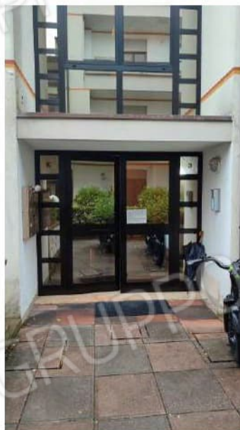
FOTO 2: vista vano scala comune
