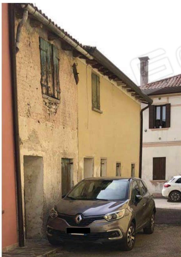
Foto n. 10 - Fronte Ovest abitazione
