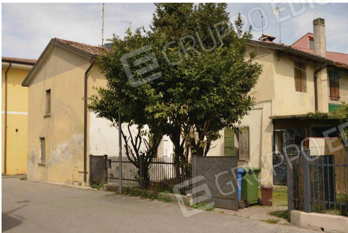
Foto n. 5 - Via San Martino - Fronte sud-est
