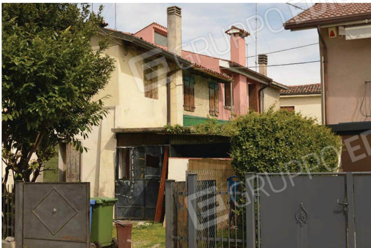
Foto n. 8 - Via San Martino ingresso carraio abitazione
