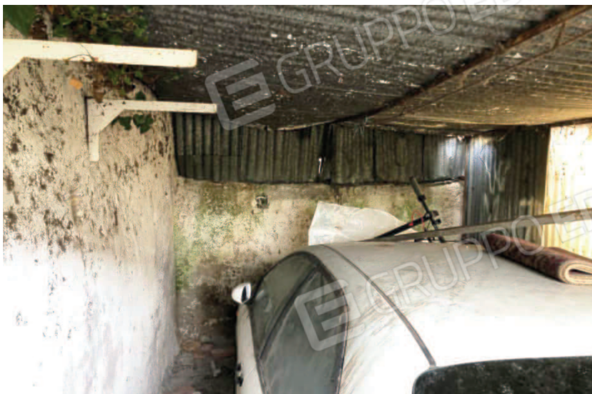
Foto n. 56 – Garage sub 2 - Particolare copertura
