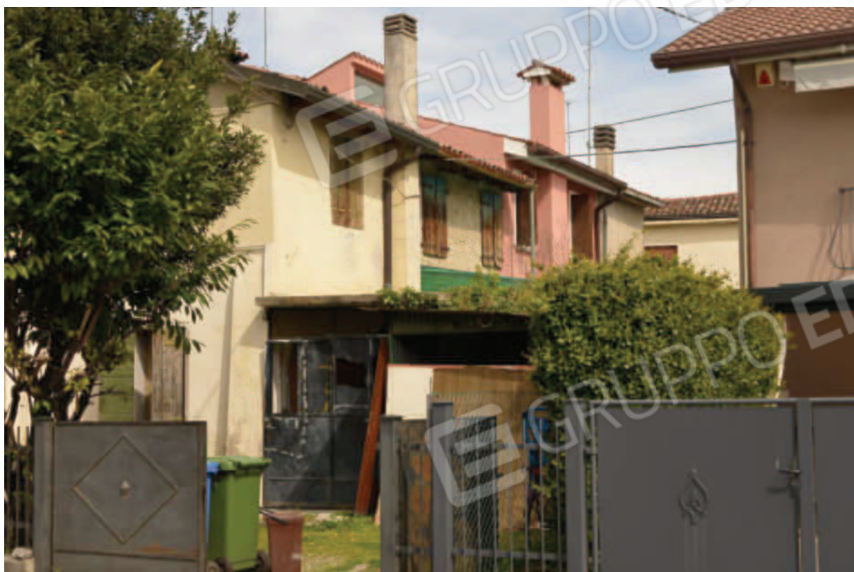
Foto n. 19 – Fronte Sud accesso carraio
