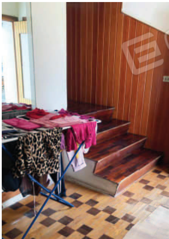
Foto n. 29 - 30 – Vano ingresso P.T.
