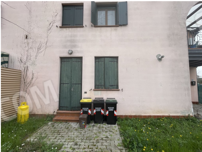
foto 3 particolare prospetto est
