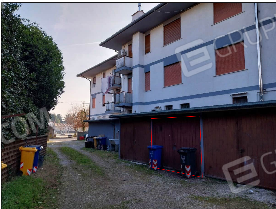
4) Lato est – garage
