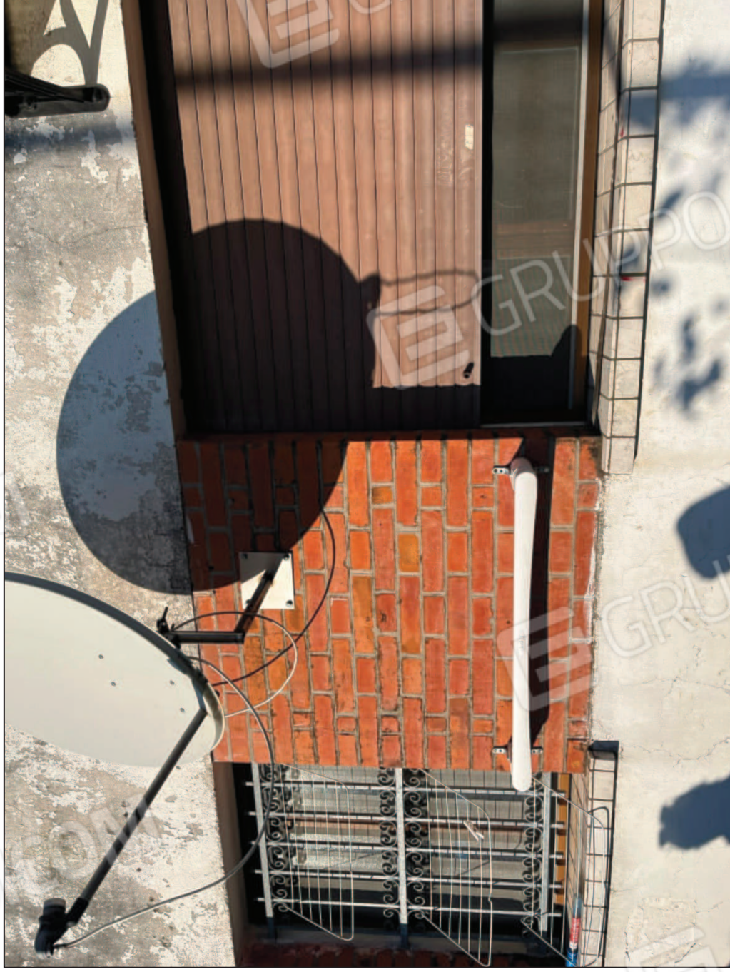
Foto n. 6 – Foto del fabbricato lato est.
