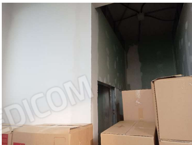
(Docce e WC degli spogliatoi al grezzo)
