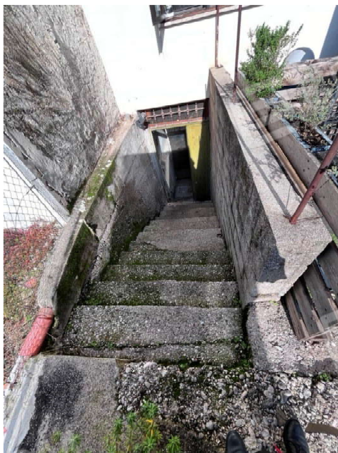
accesso alla cantina interrata dal cortile
