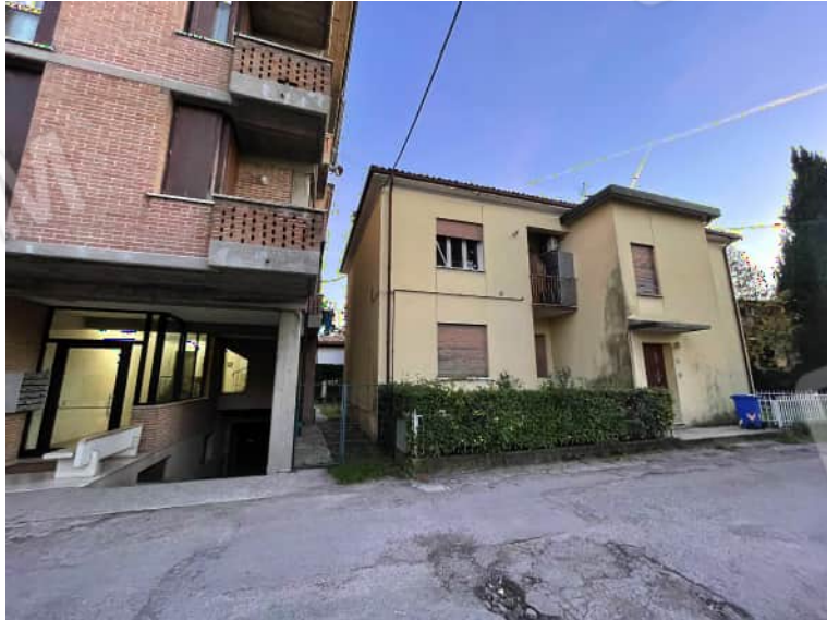
Prospetto Nord-Ovest dell'edificio (appartamento al primo piano)
