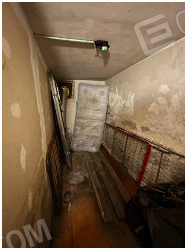
Autorimessa (piano seminterrato)
