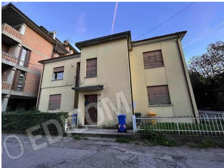
Prospetto Nord-Ovest dell'edificio (appartamento al primo piano)
