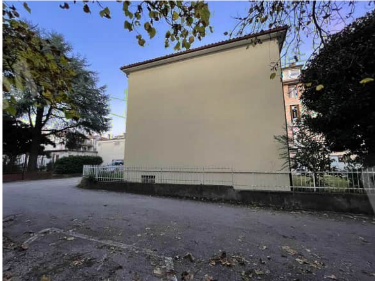
Prospetto Sud-Ovest dell'edificio (appartamento al primo piano)
