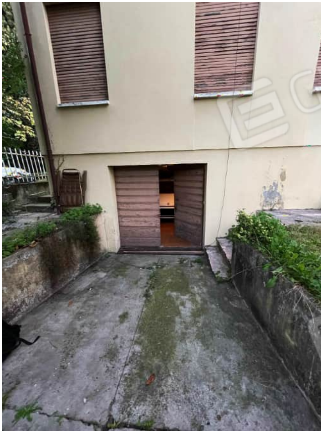
Autorimessa (piano seminterrato)
