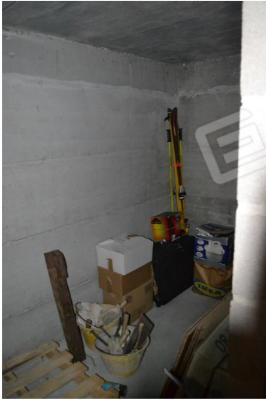
Foto 12. Interno deposito sub.28
