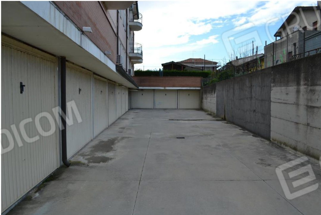
Foto 5. Viabilità carraia di accesso ai garages interrati
