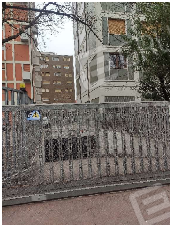
FOTO N. 3 – rampa condominiale di accesso ai garage da via Firenze
