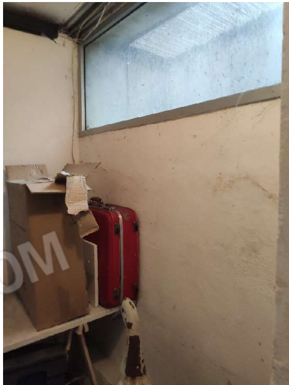
FOTO N. 18 – ripostiglio al piano interrato
