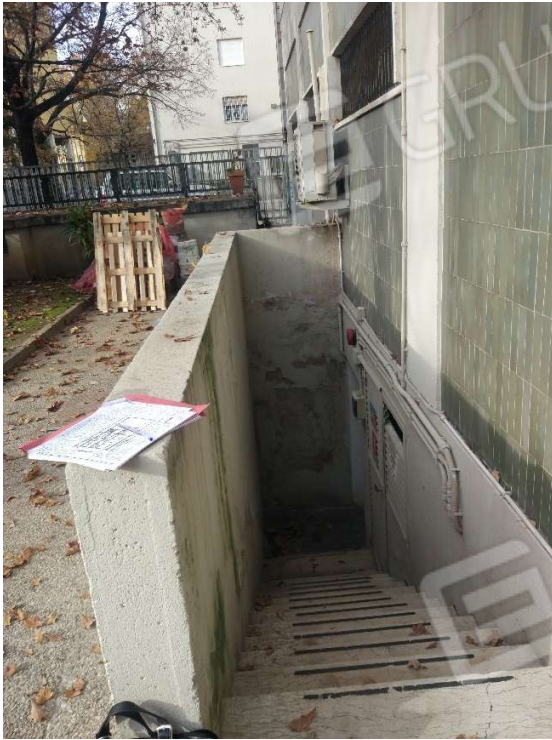
FOTO N. 5- accesso pedonale ai garage
