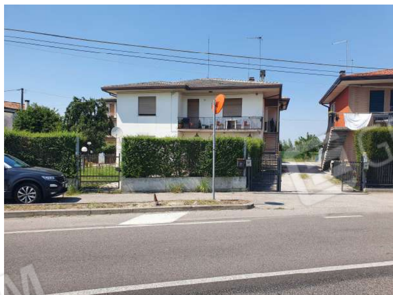
Foto n. 2: Lotto n.1 - Vista Sud del fabbricato del quale fa parte l'unità abitativa oggetto di pignoramento.
