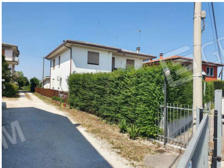
Foto n. 4: Lotto n.1 Vista Sud-Ovest del fabbricato del quale fa parte l'unità abitativa oggetto di pignoramento.
