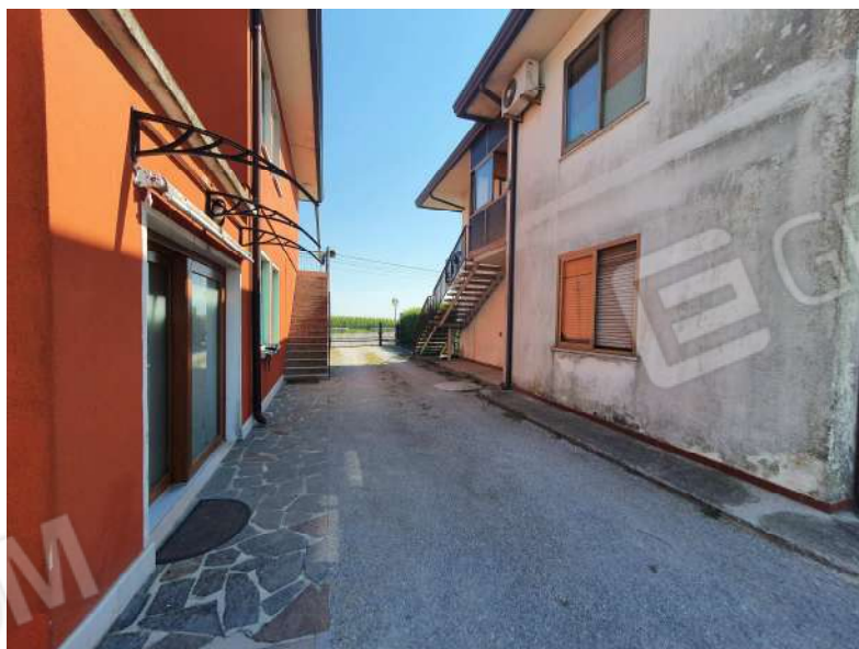
Foto n. 14: Vista dell'accesso carraio in reciproca servitù di passaggio con terzi.
