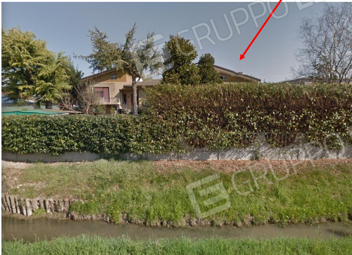
Vista dell'edificio dalla via Cavin Maggiore. La porzione pignorata è evidenziata dalla freccia
