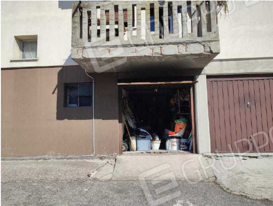
Foto n. 5 Vista da Ovest su Garage
