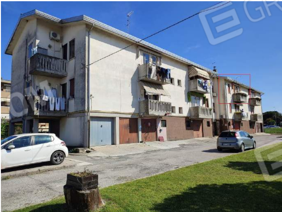
Foto n. 4 Vista da Nord – Ovest su area manovra Garage
