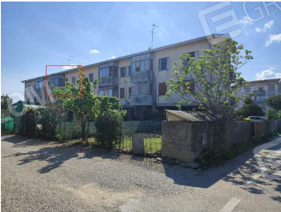
Foto n. 2 Vista da Nord-Est, da Via Marco Polo
