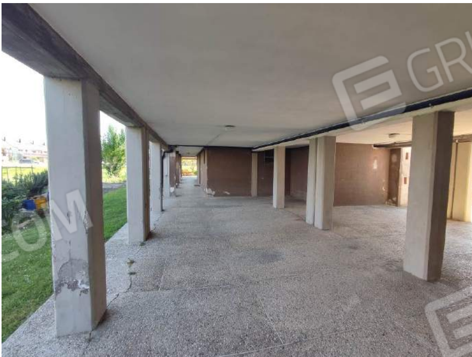
Foto n. 6 Vista da Nord su Portico Comune
