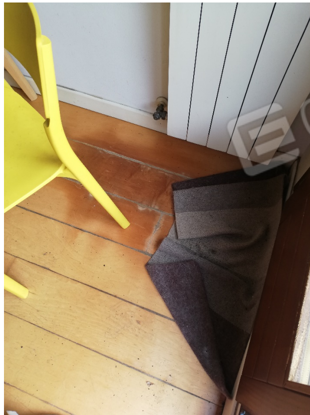
Foton.14: particolare del pavimento posto in cucina
