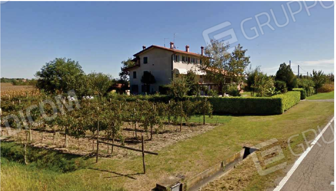
Vista del fabbricato da Ovest
