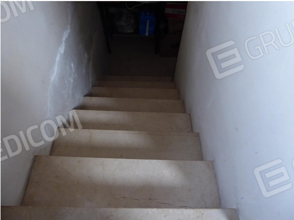
Immagine n. 9 Scale interne di accesso al piano primo
