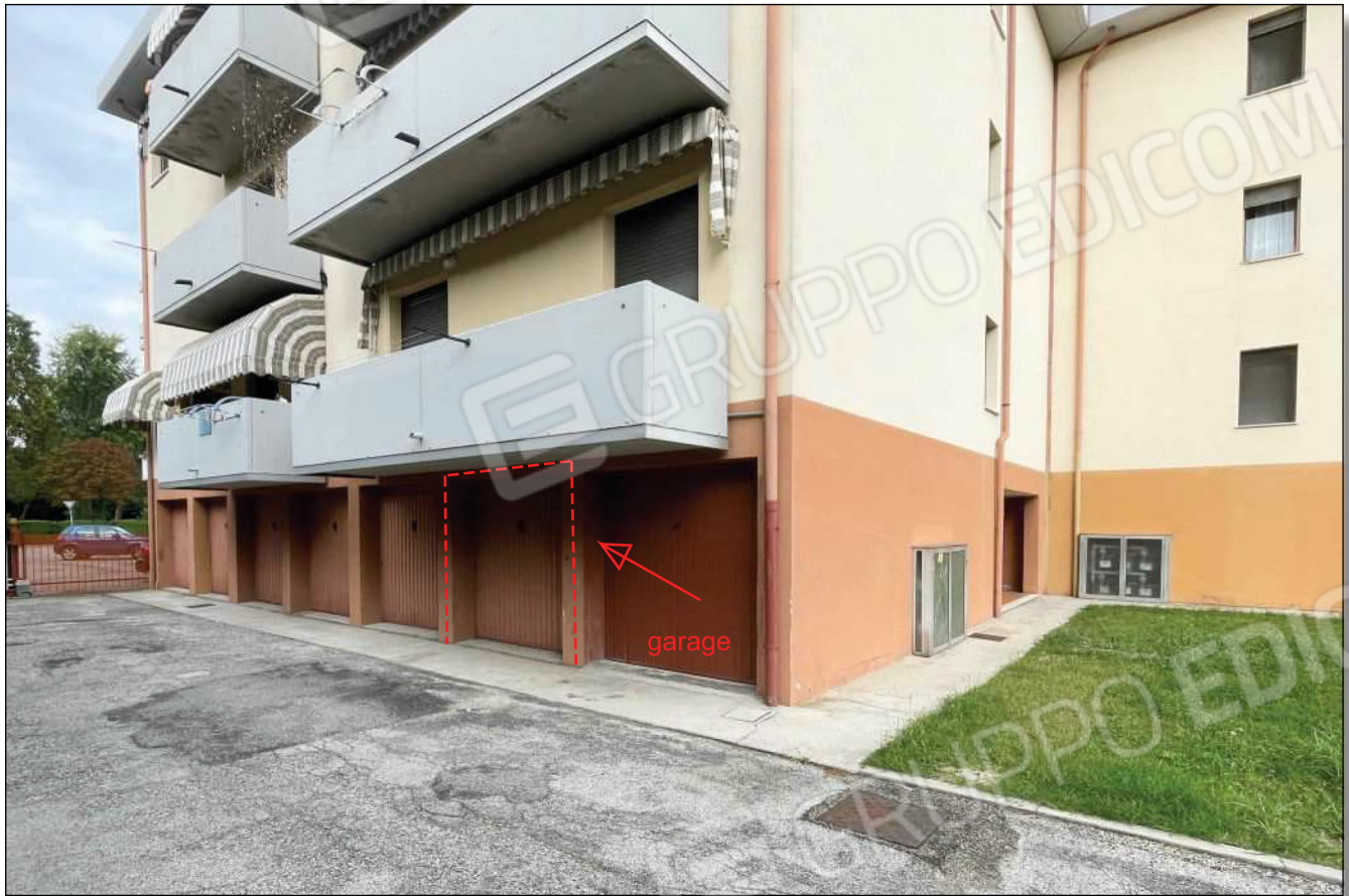
Foto n. 5) Vista del garage ad ovest
