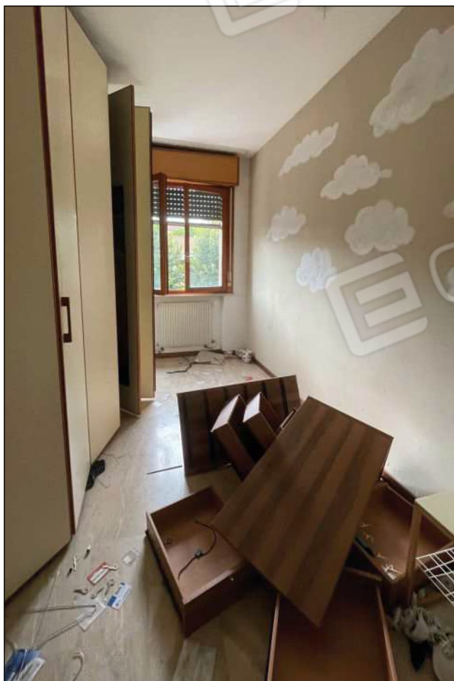
Foto n. 15) Vista della cameretta a nord/ovest
