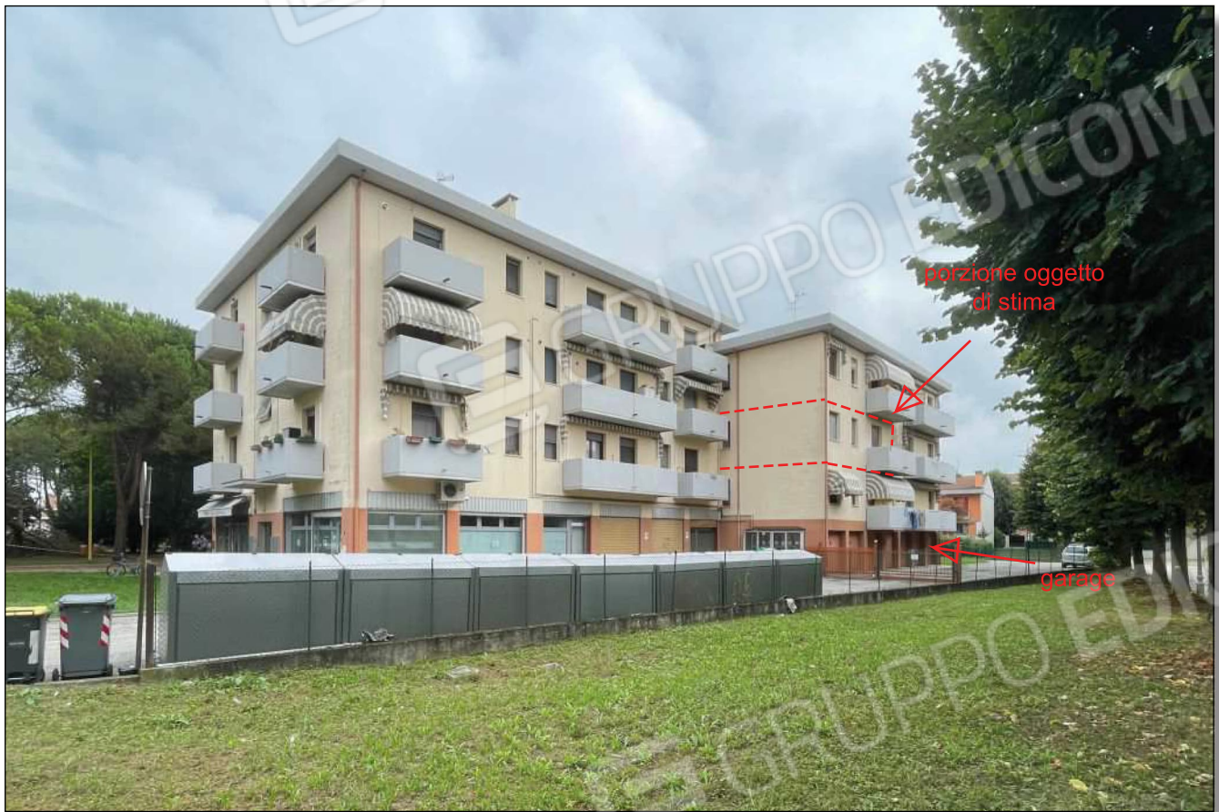
Foto n. 1) Vista del complesso da via Bernini - prospetti nord ed ovest
