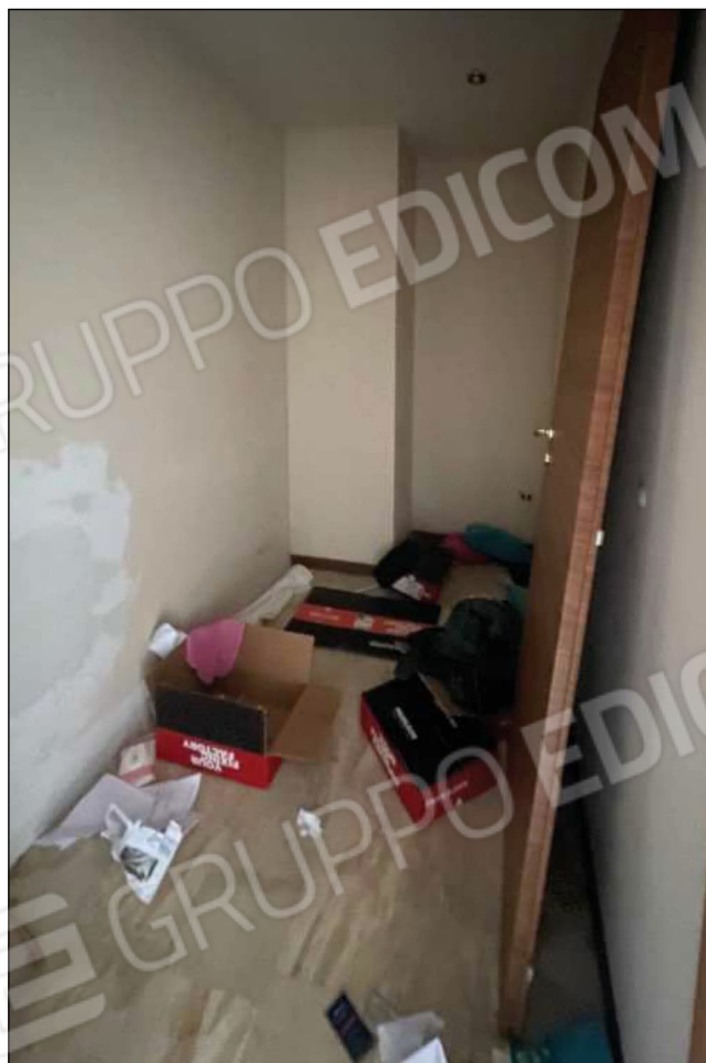
Foto n. 16) Vista della cabina armadio abusiva
