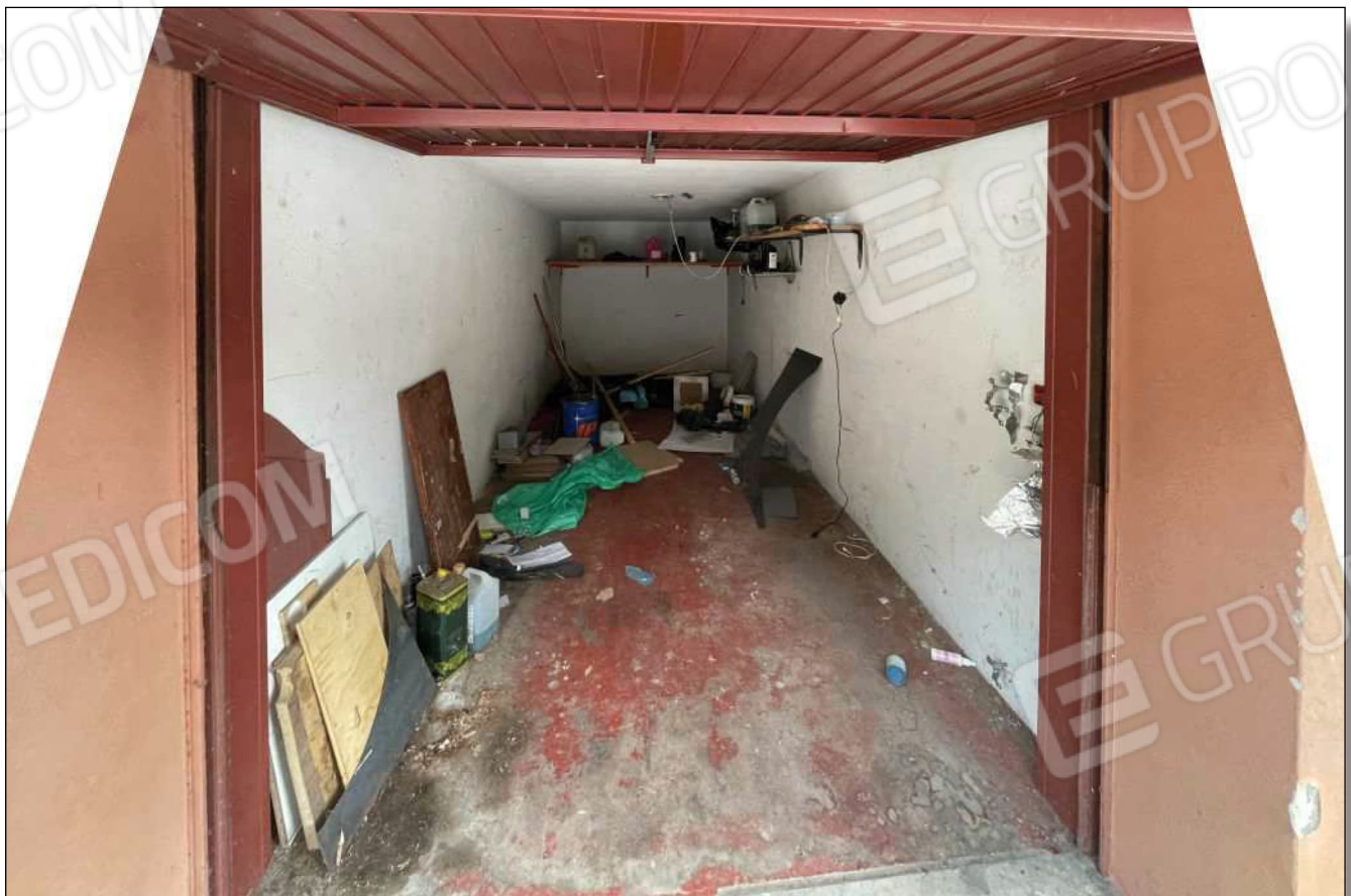
Foto n. 6) Vista interna del garage
