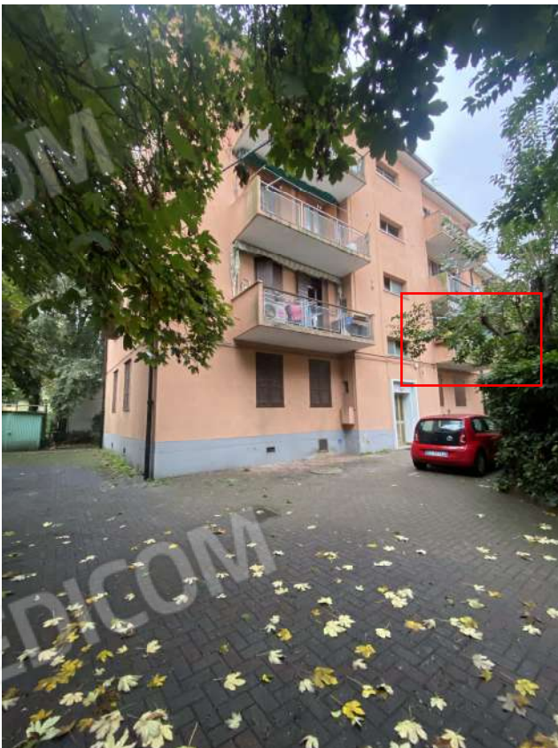
FOTO 4: Vista esterna fabbricato
