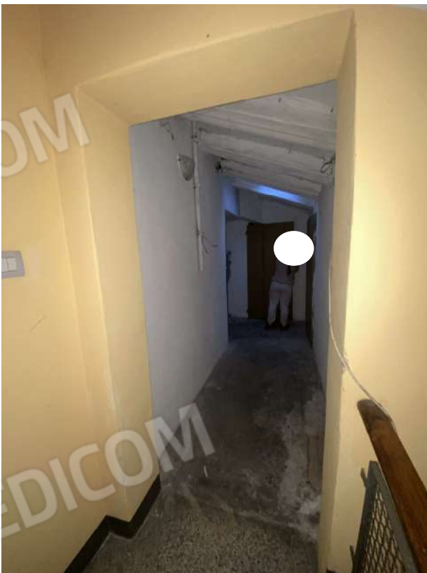
FOTO 16: Accesso locale nel sottotetto
