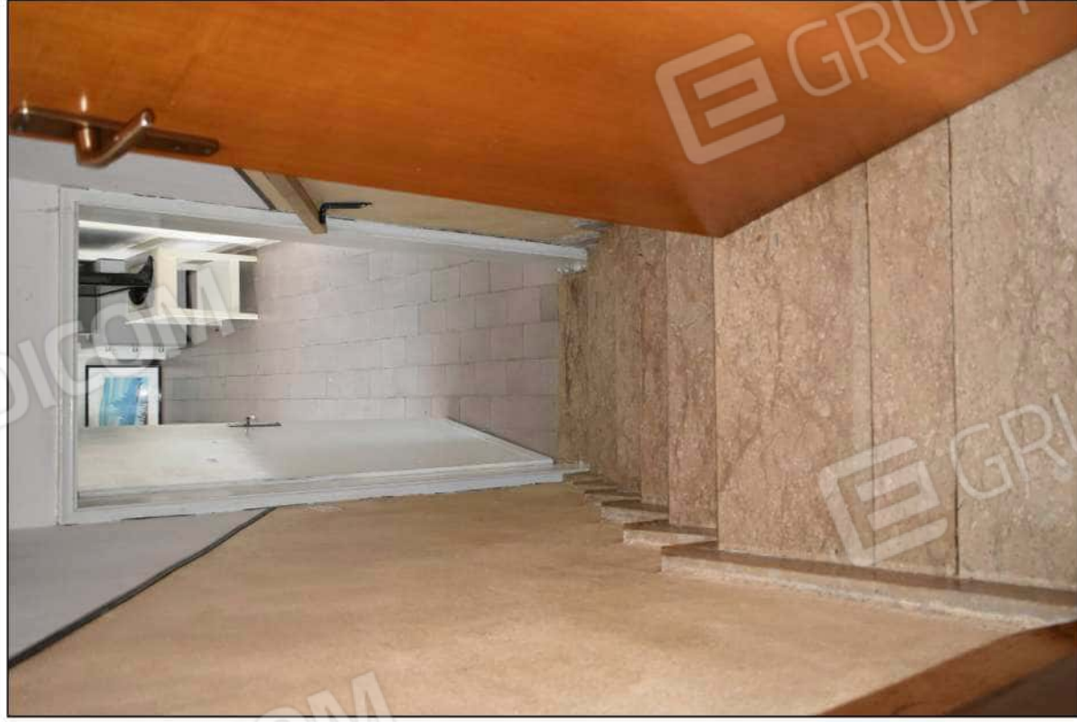
foto 36 - scala collegamento piano rialzato / PT
