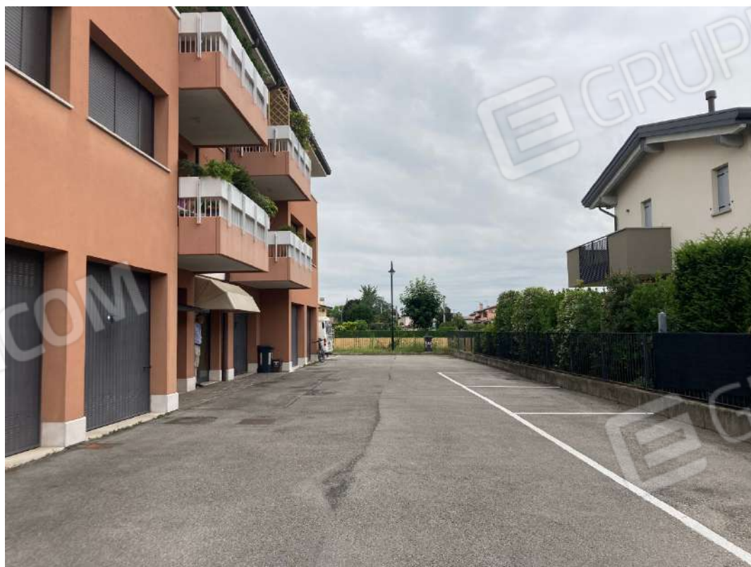
Foto n. 2: vista del fabbricato da nord
