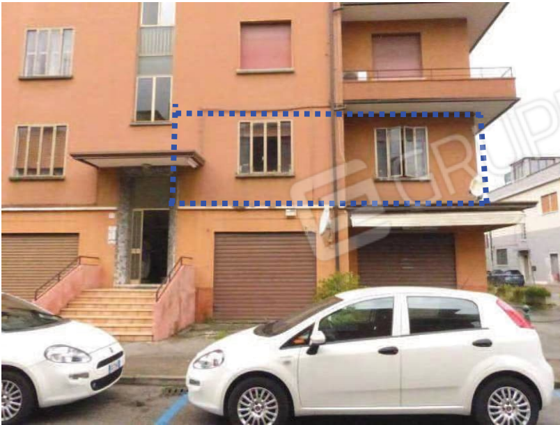
Foto 1 – Vista da Via Oslavia
