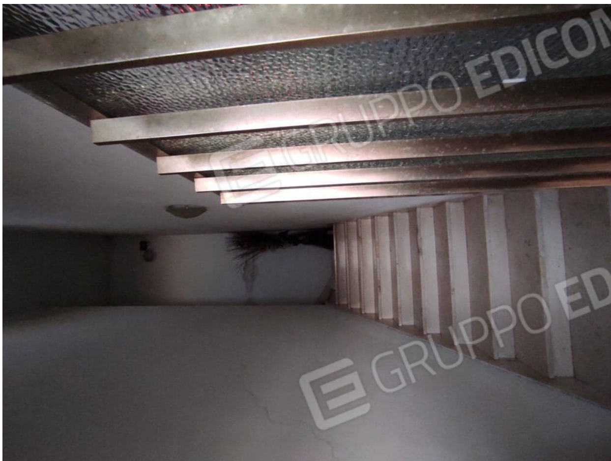
FOTO 03 vano scala comune.jpg
