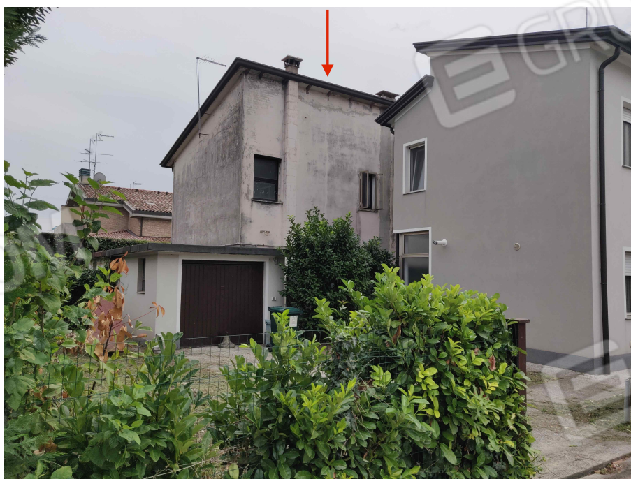
foto 2: veduta dell'u.i. corpo A – abitazione da via Vittorio Veneto
