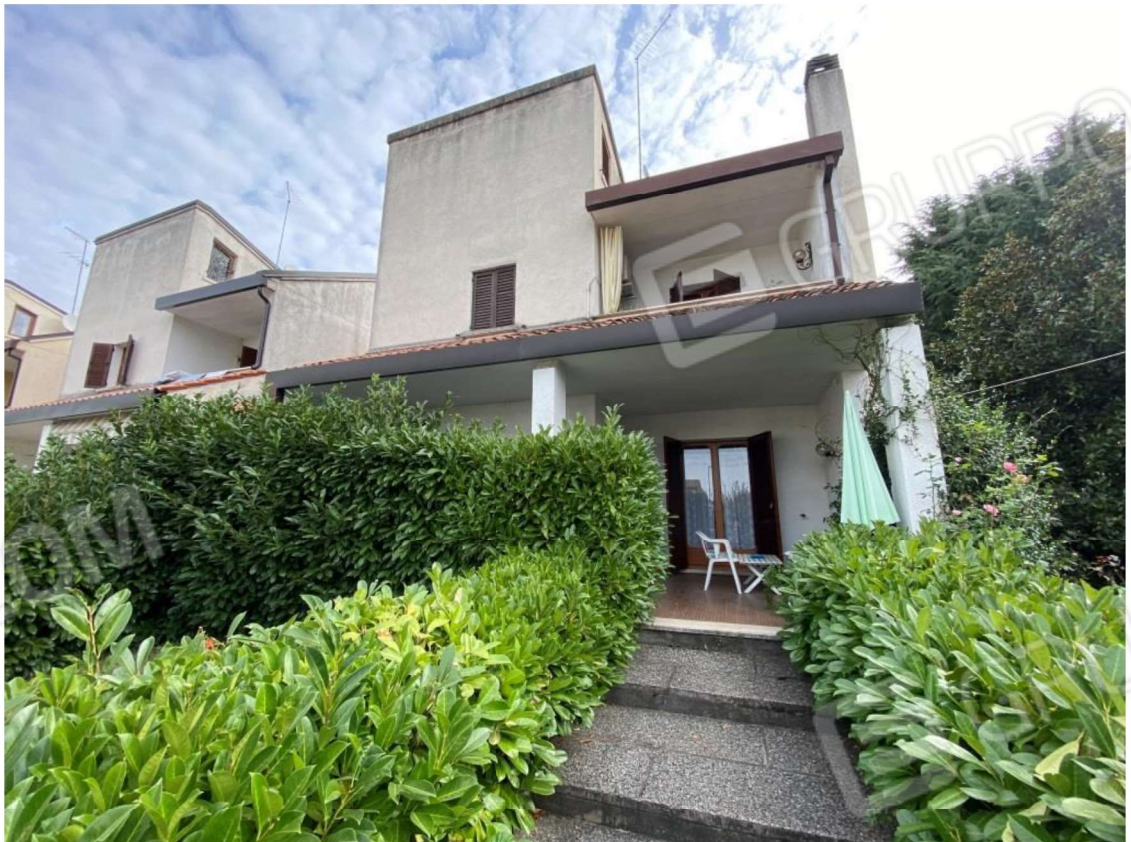
FOTO 2 ESTERNO ACCESSO ABITAZIONE
