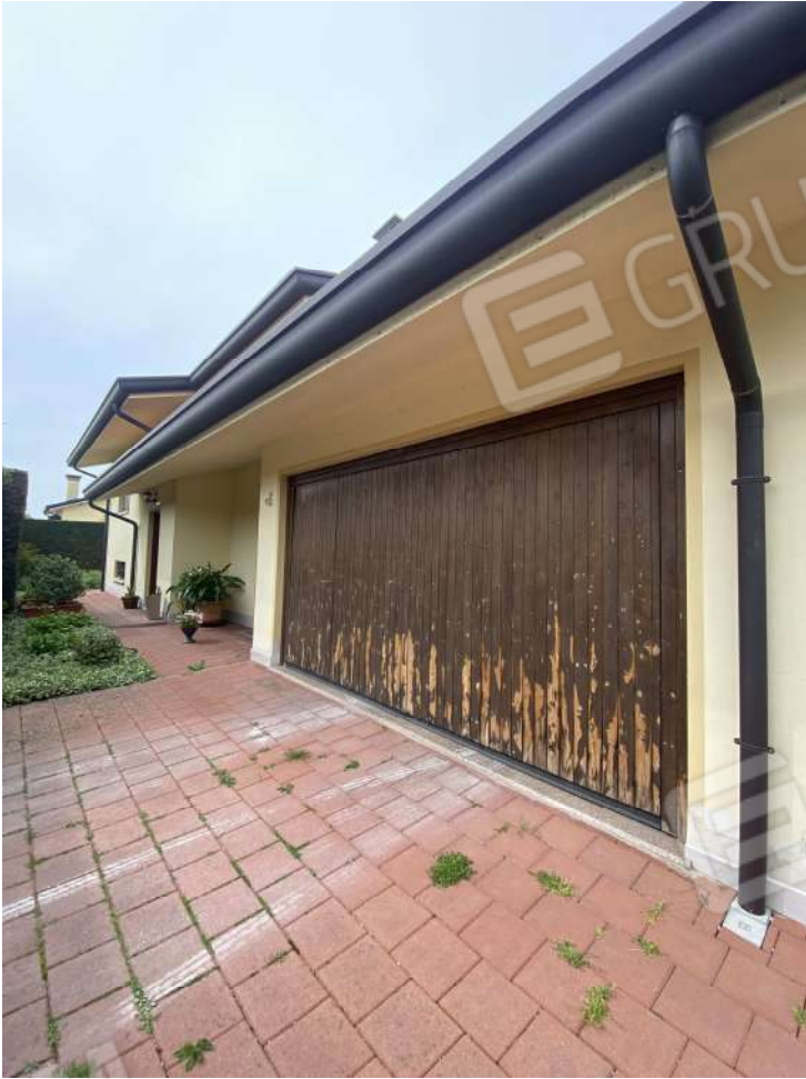
FOTO 3: Vista fabbricato lato est
