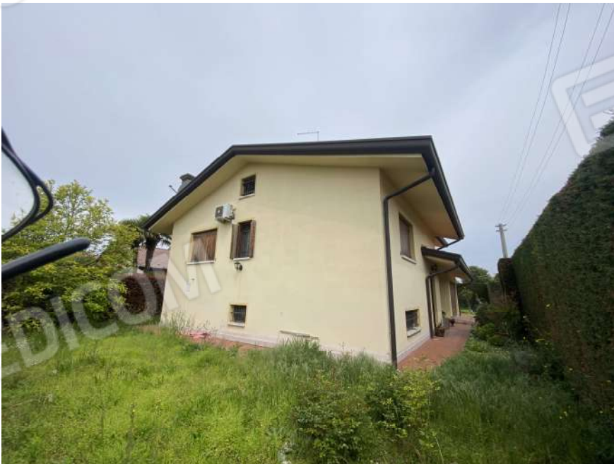
FOTO 4: Vista fabbricato lato sud
