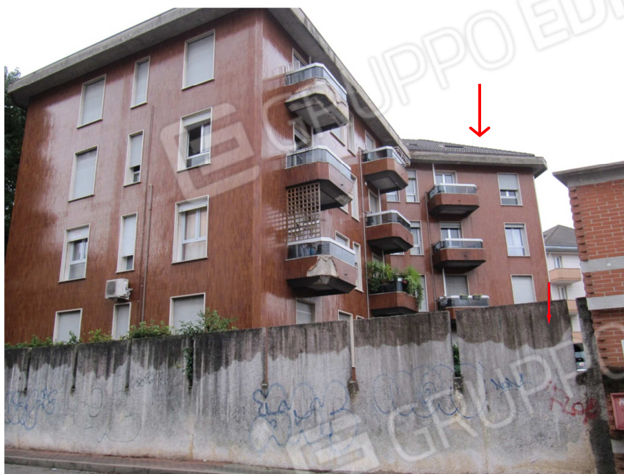
Il fronte nord-est visto da via Bissa
