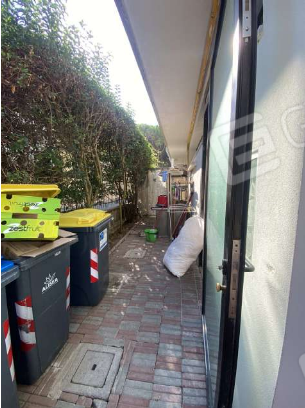
FOTO 7: Vista lato Est del fabbricato
