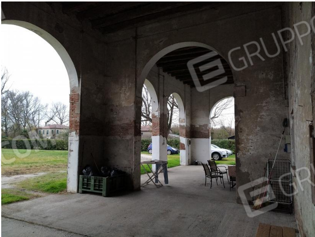
Foto 10 Vista del portico.
