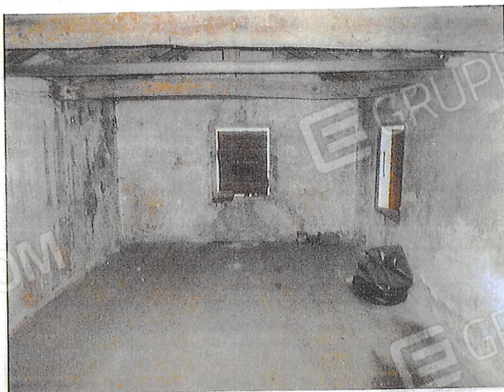
Foto n° 8 : Vano al primo piano del fabbricato produttivo – Lotto 1.
