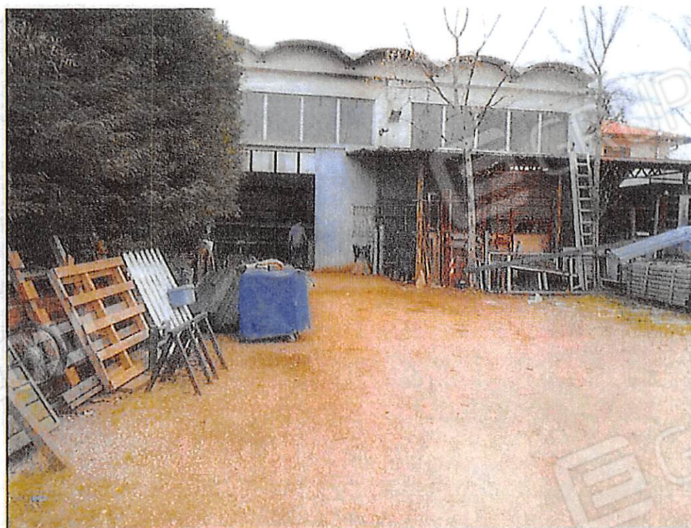
Foto n° 10 : Capannone produttivo – vista esterna – Lotto 1.
