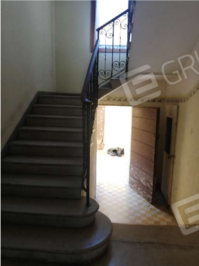
Foto n. 5: vano scala condominiale
