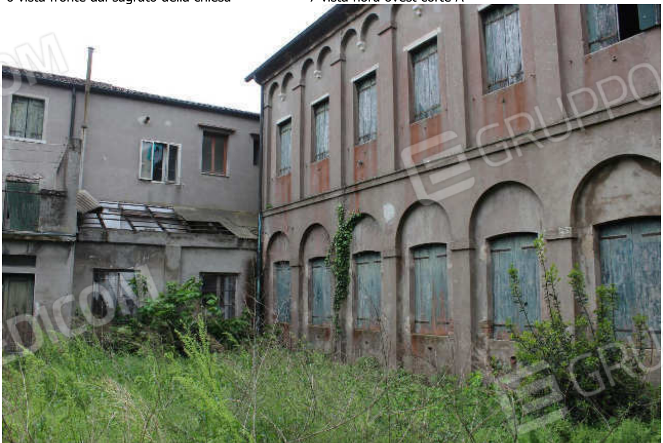
8 vista sud est corte A
