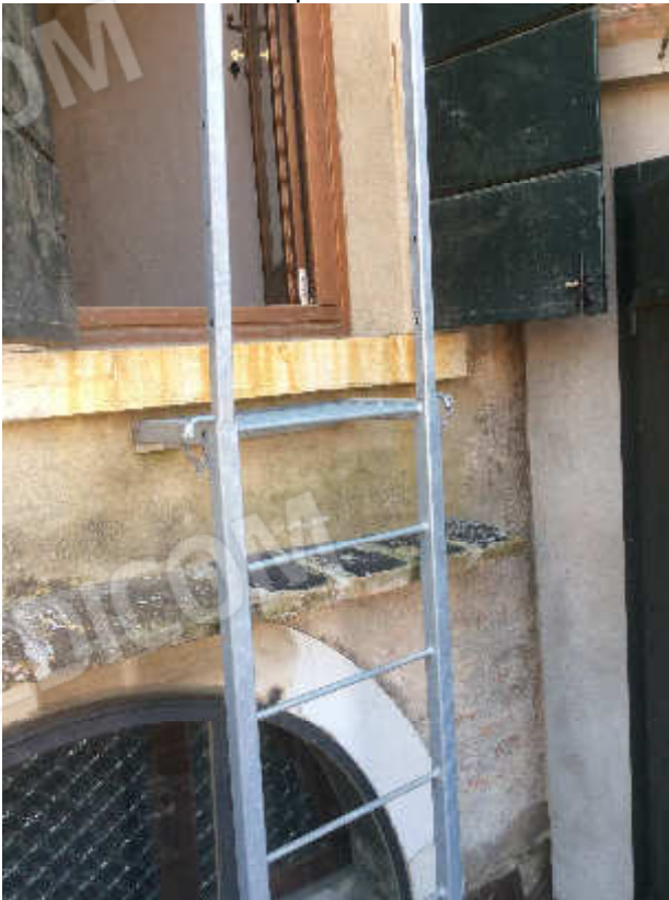
52 scaletta di accesso al sottotetto
