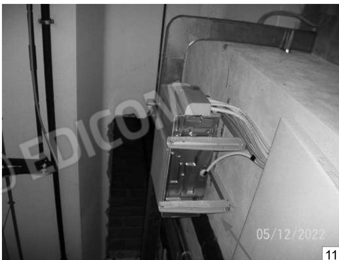
Gruppo esterno impianto di condizionamento posizionato all'interno del magazzino artigianale
