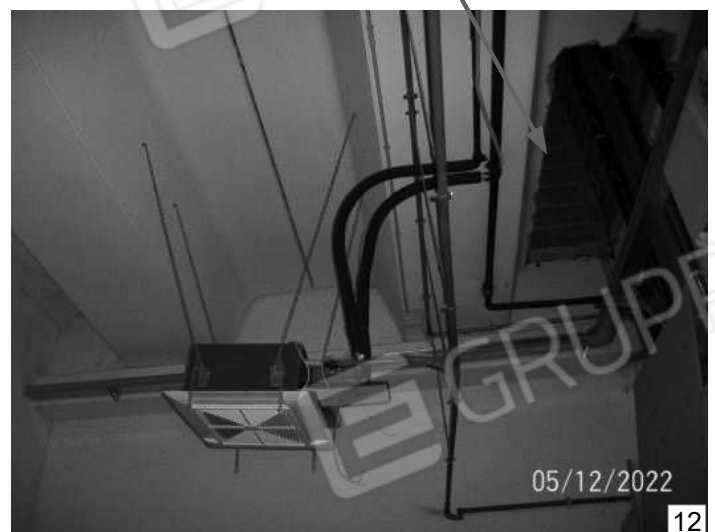
Gruppo esterno impianto di condizionamento posizionato all'interno del magazzino artigianale
