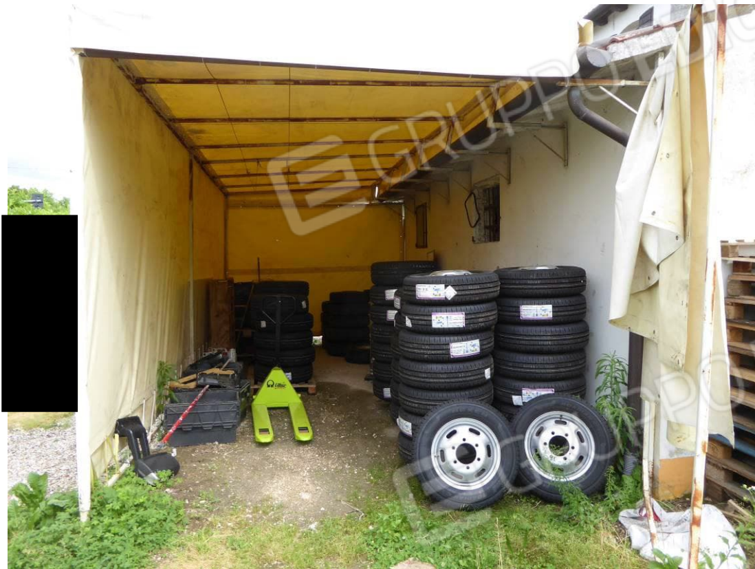
Foto 30 – Part. 30 tettoia su scoperto nord in assenza di titolo edilizio
