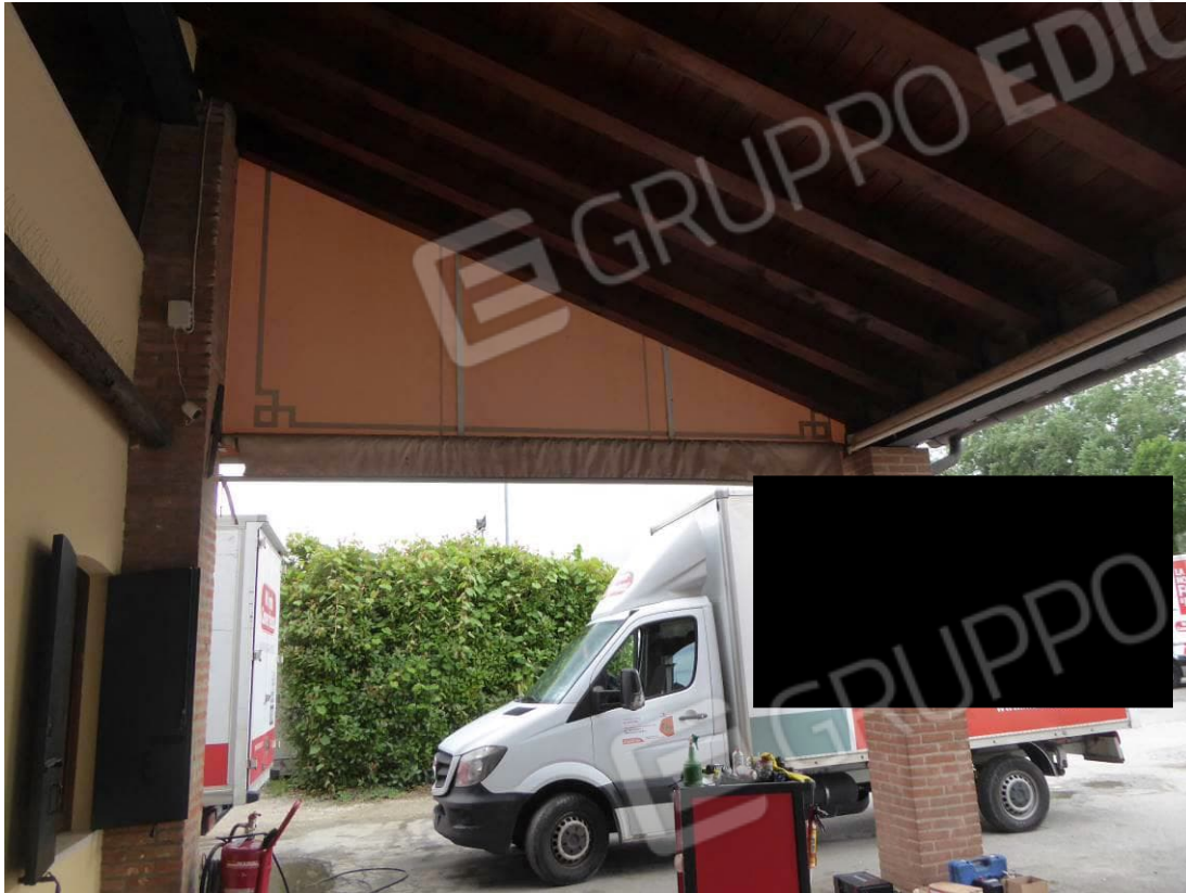
Foto 52 – Part. 125 sub 2 portico esterno
