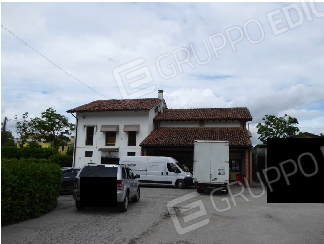
Foto 82 – Part. 125 sub 2 prospetto Ovest
