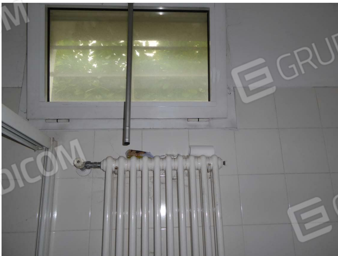
Foto 55 – Part. 125 sub 2 servizio igienico piano terra
