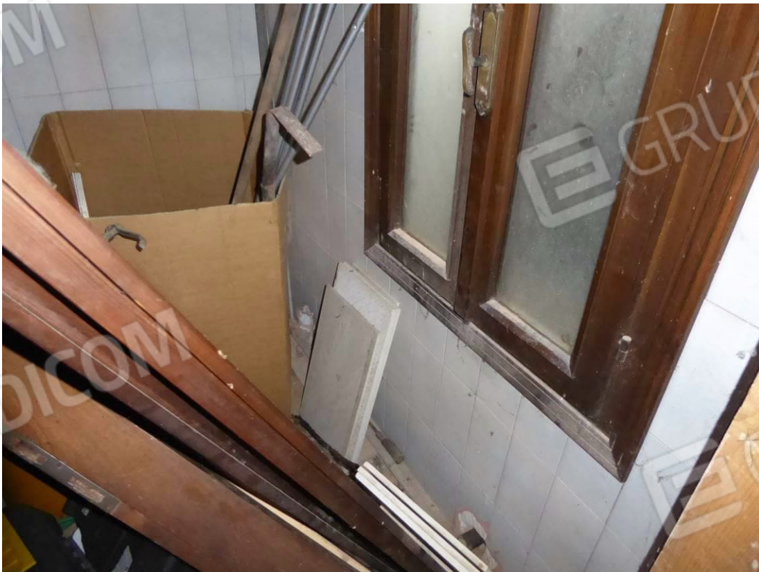
Foto 6 – Part. 30 sub. 2 servizio igienico
