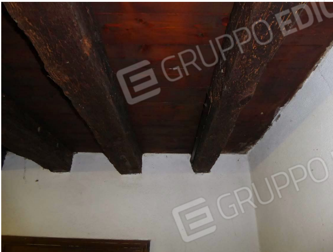
Foto 9 – Part. 30 sub. 2 magazzino
