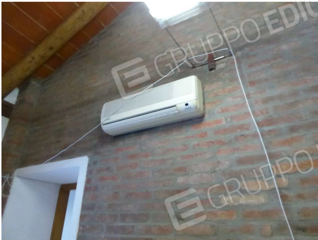
Foto 74 – Part. 125 sub 2 uffici piano primo
