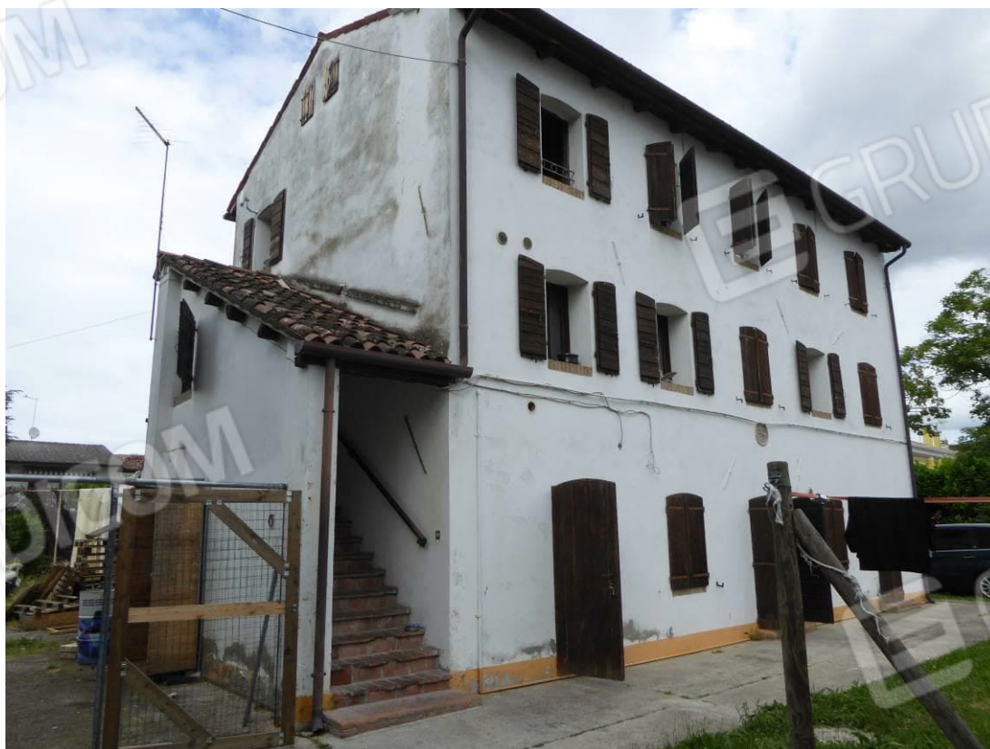
Foto 39 – Part. 30 vista da sud/ovest
