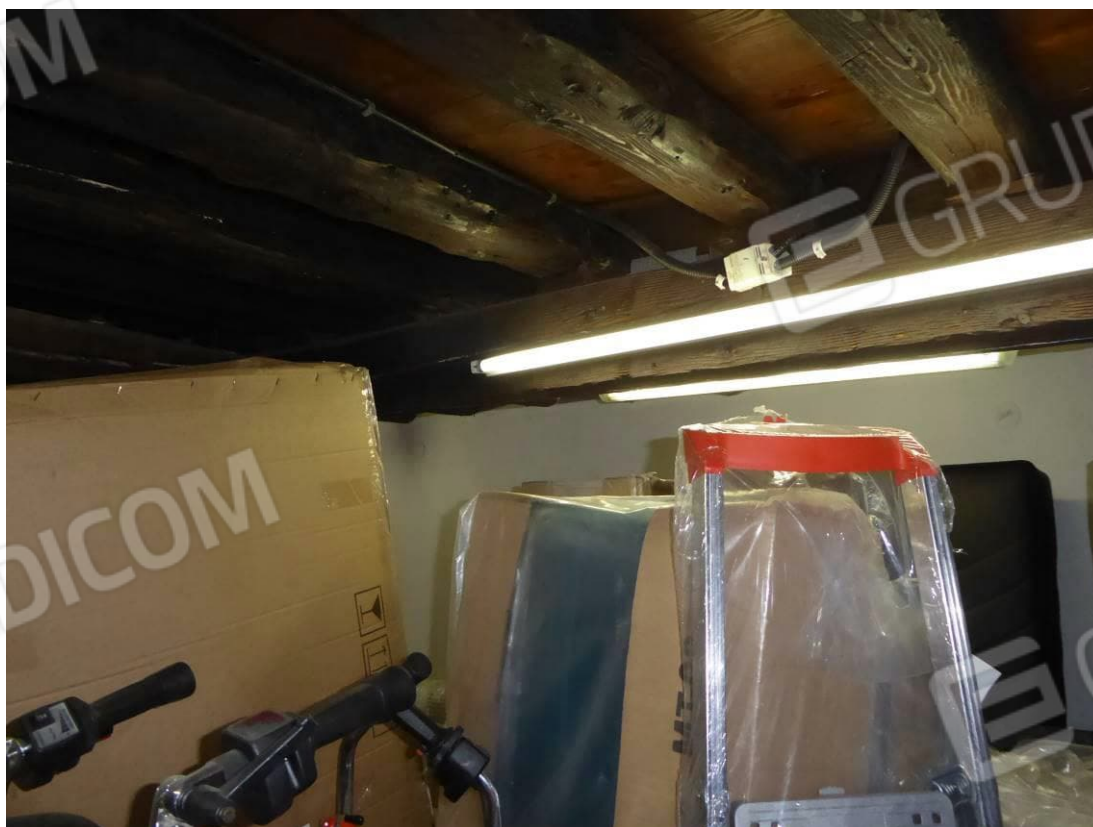
Foto 12 – Part. 30 sub. 2 magazzino
