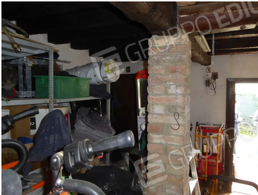
Foto 15 – Part. 30 sub. 2 magazzino
