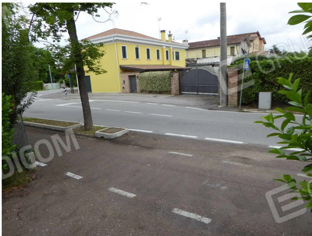
Foto 2 – accesso carrai Via Chiesa di Campocroce
