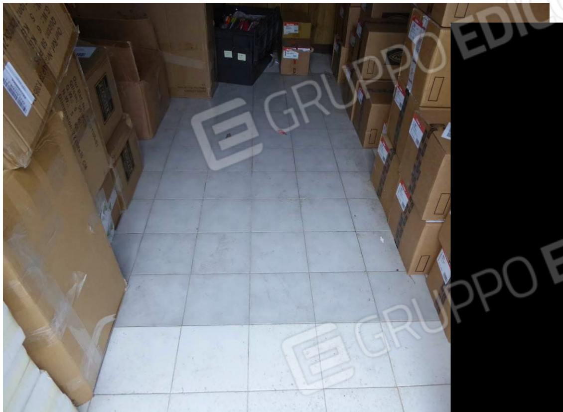
Foto 17 – Part. 30 sub. 2 magazzino angolo sud/ovest
