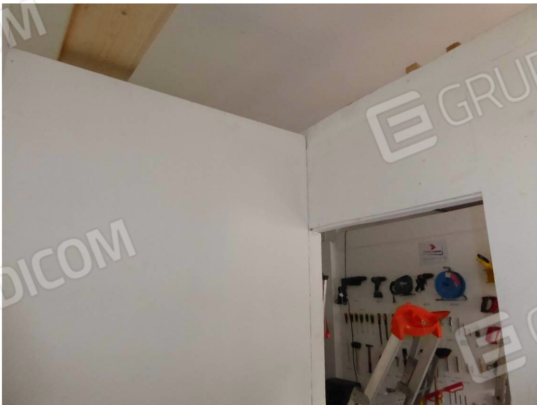
Foto 48 – Part. 125 sub 2 deposito attrezzature nord
