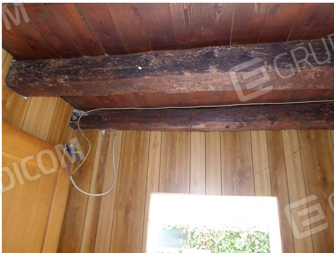
Foto 18 – Part. 30 sub. 2 magazzino angolo sud/ovest
