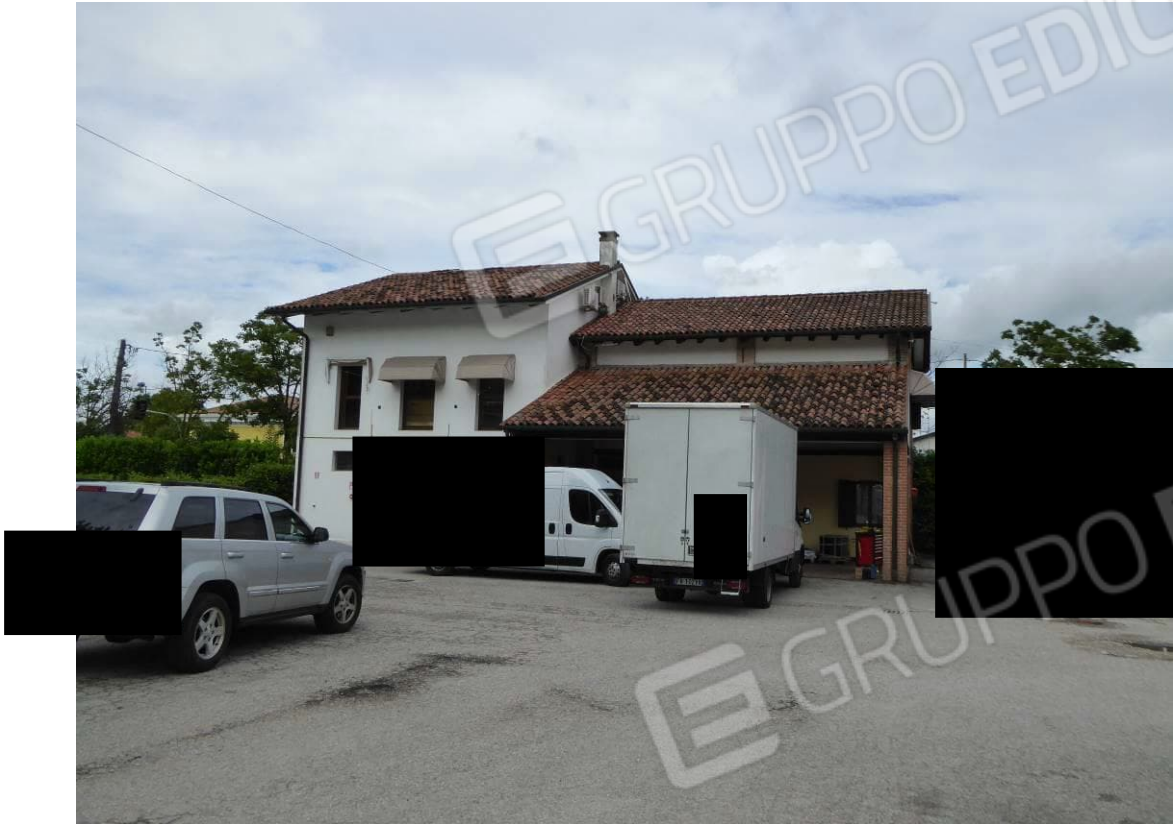
Foto 84 – Part. 125 sub 2 prospetto Ovest
