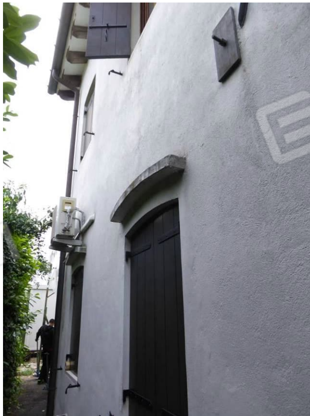
Foto 67 – Part. 125 sub 2 prospetto est
