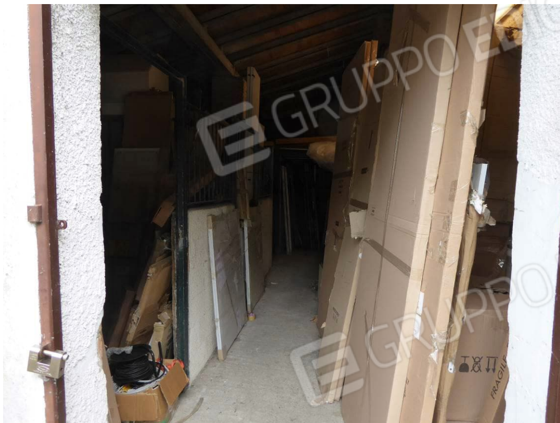
Foto 20 – Part. 30 sub. 3 ingresso scuderia
