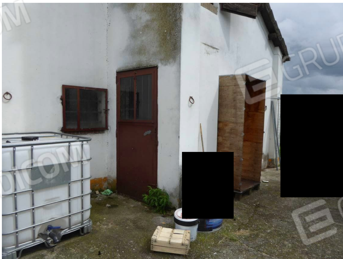
Foto 33 – Part. 30 sub. 2 ingresso sottoscala/ripostiglio
