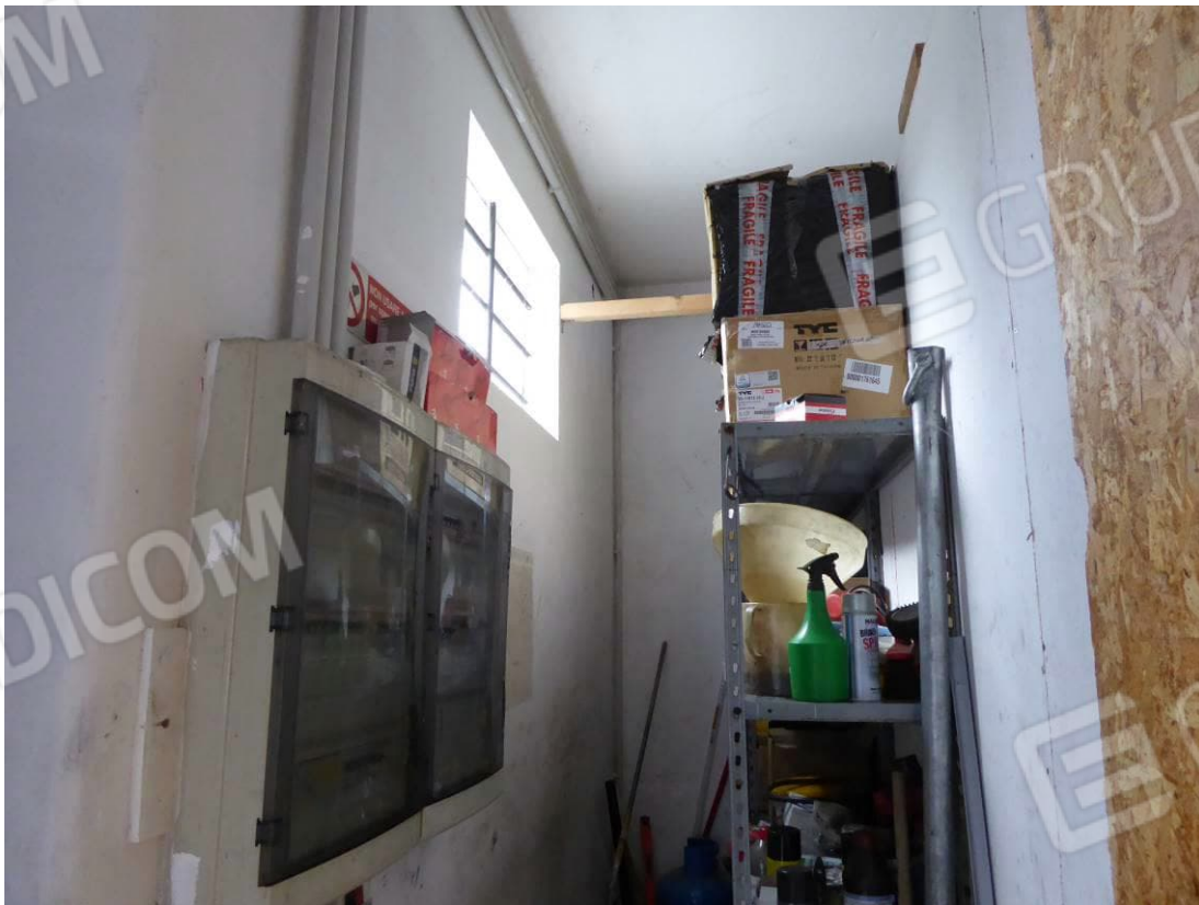
Foto 50 – Part. 125 sub 2 deposito attrezzature nord
