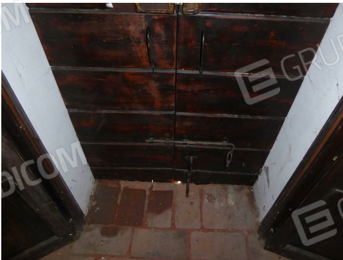
Foto 10 – Part. 30 sub. 2 magazzino
