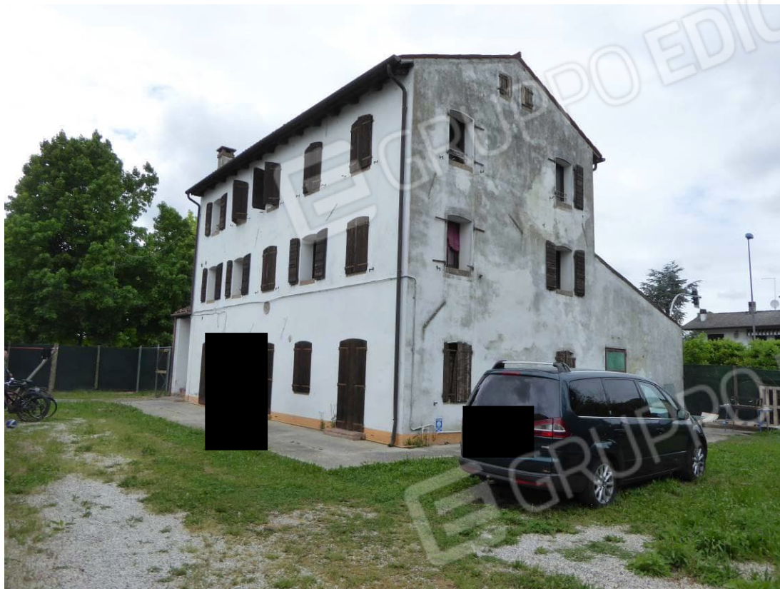
Foto 3 – Vista da sud/est fabbricato su particella 30 sub. 2 e 3
