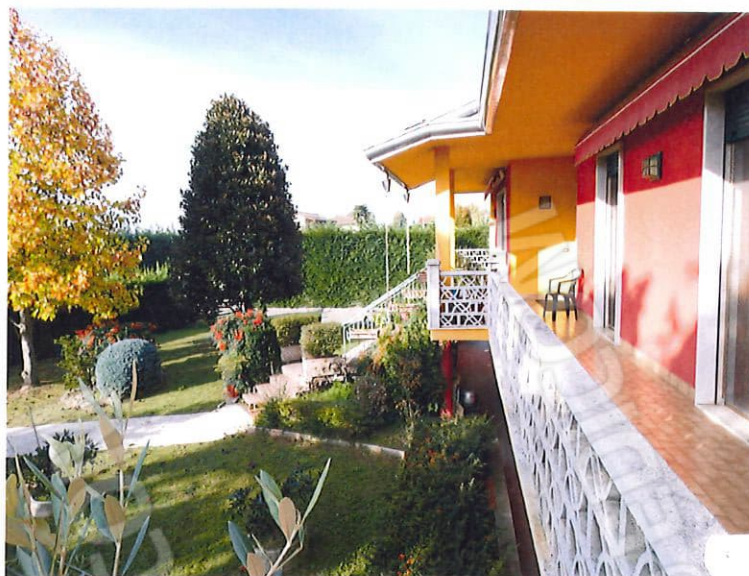
foto 6 terrazzino lato sud
