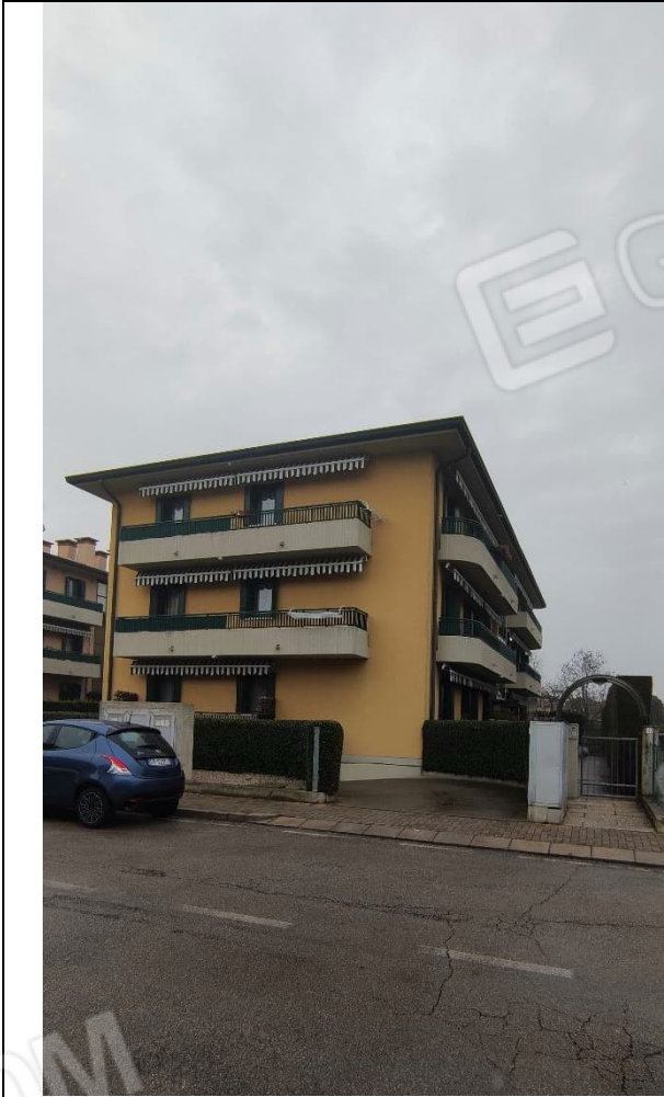
FOTO 1_AFFACCIO SU STRADA DEL CONDOMINIO TULIPANO CIV. 17
