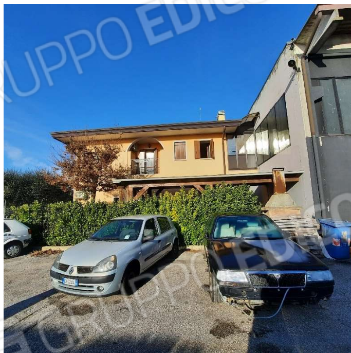
Foto 2 – scorcio prospetto sud est – ingresso uffici
