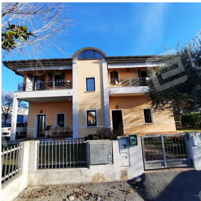
Foto 1 - Prospetto Sud Ovest – Ingresso laboratorio
