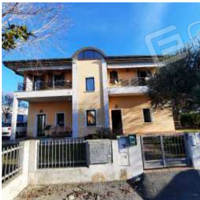
Foto 1 - Prospetto principale Sud Ovest-Ingresso uffici
