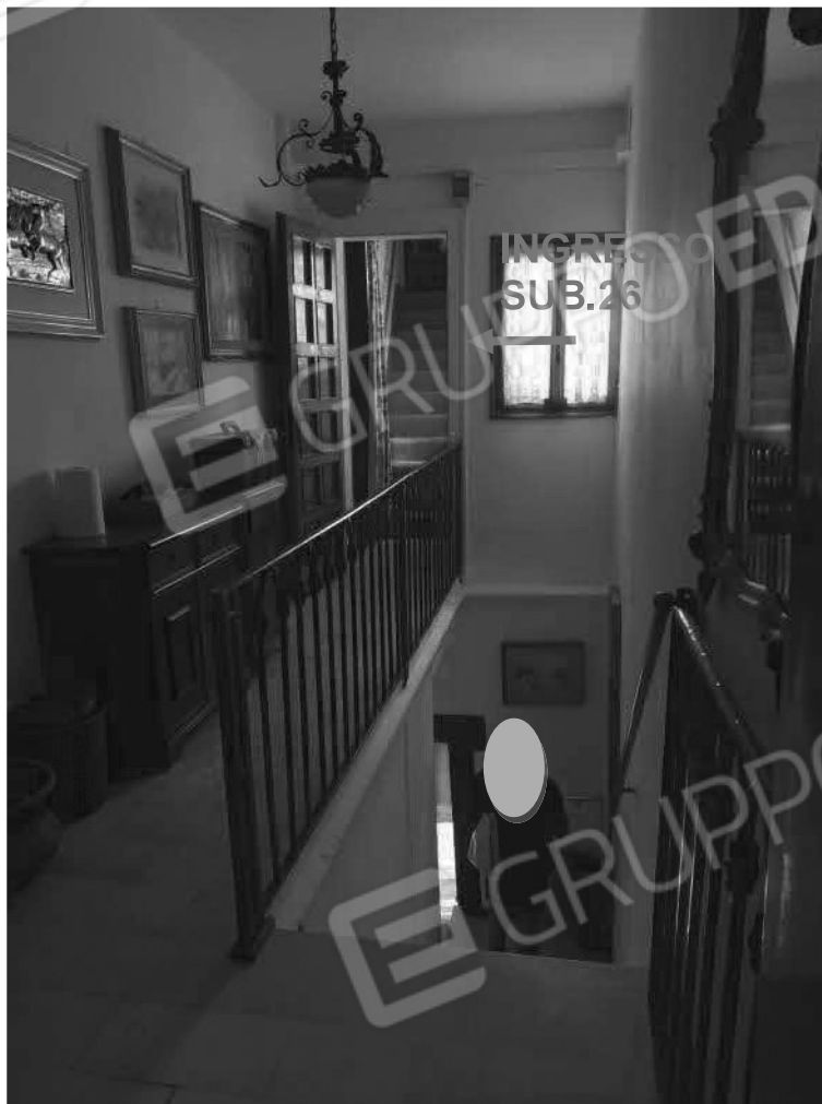
Foto 37: Lotto 1/2- Scala interna che disimpegna ai Subb.18-26.
