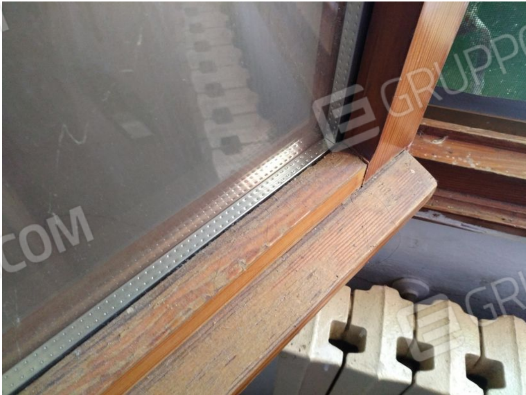
Foto 17 Particolare di un serramento.
