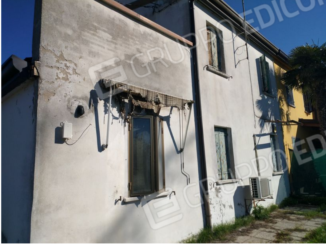
Foto 8 Vista dell'edificio oggetto di stima.
