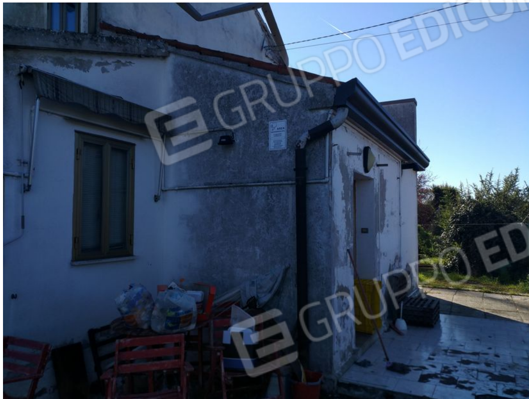
Foto 6 Vista dell'edificio oggetto di stima.
