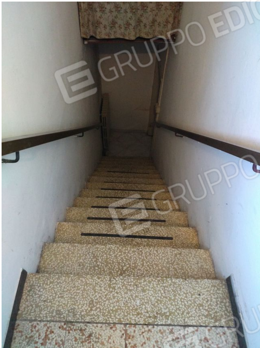
Foto 10 Scala di collegamento interna.
