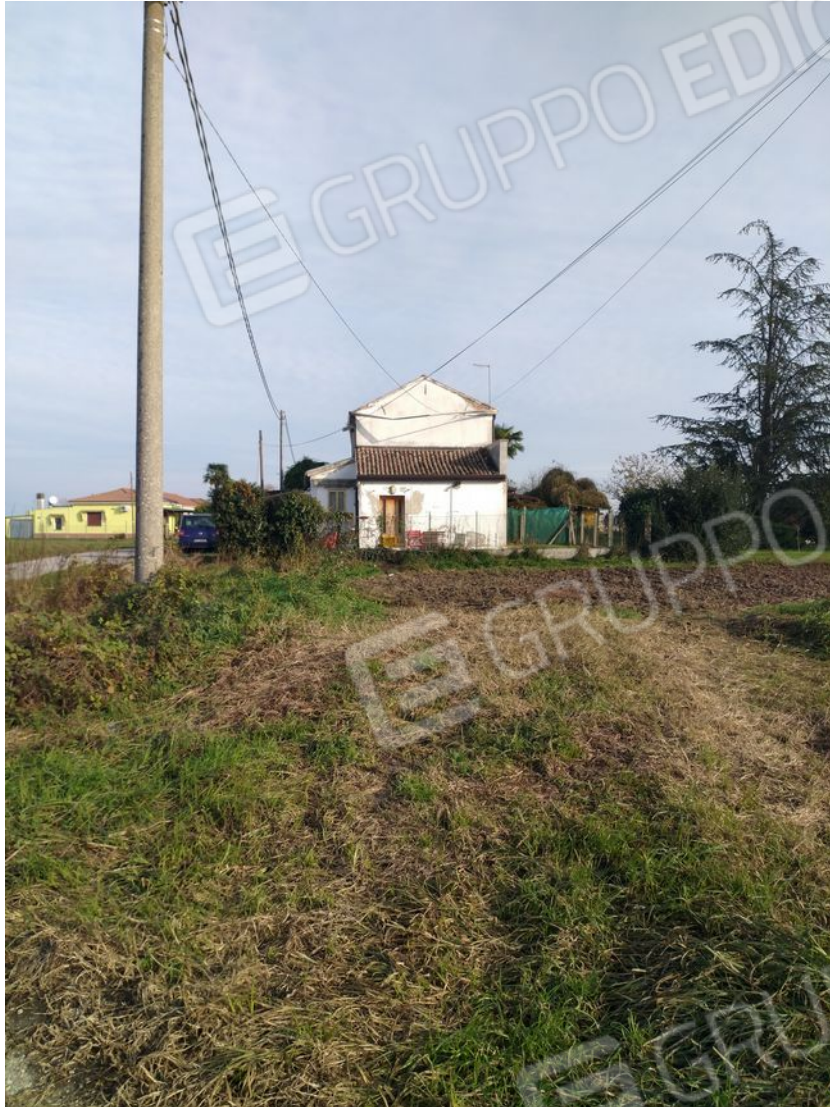
Foto 3 Vista dell'edificio oggetto di stima.
