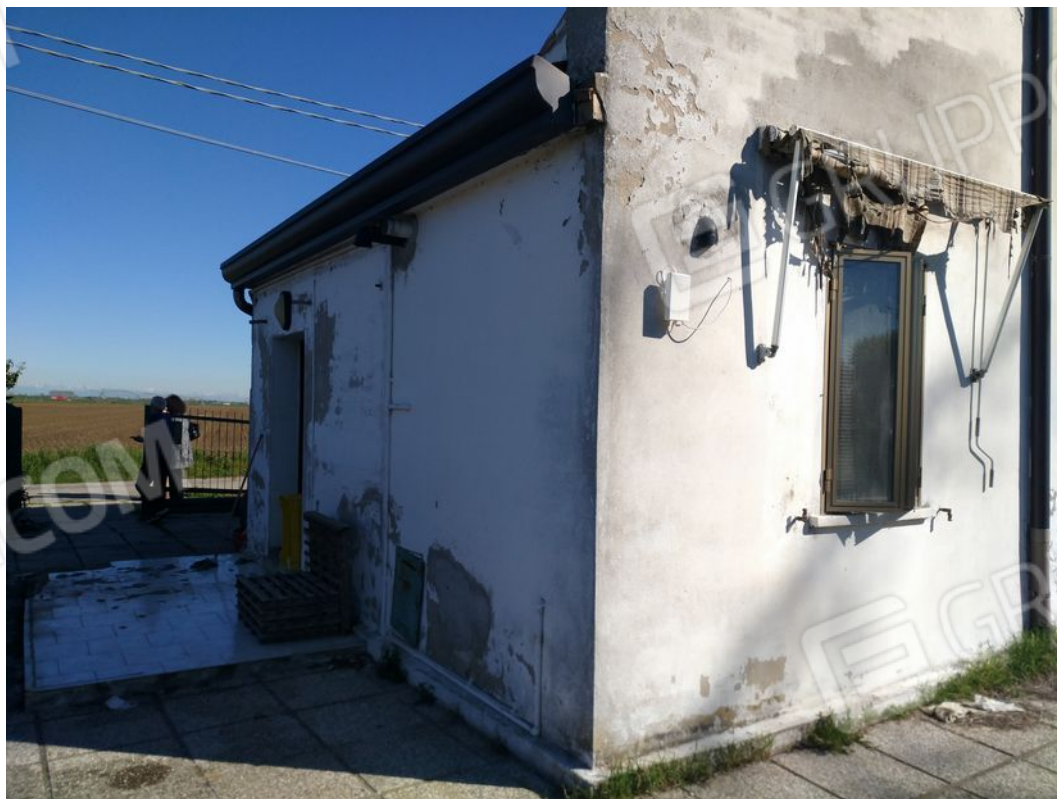
Foto 7 Vista dell'edificio oggetto di stima.
