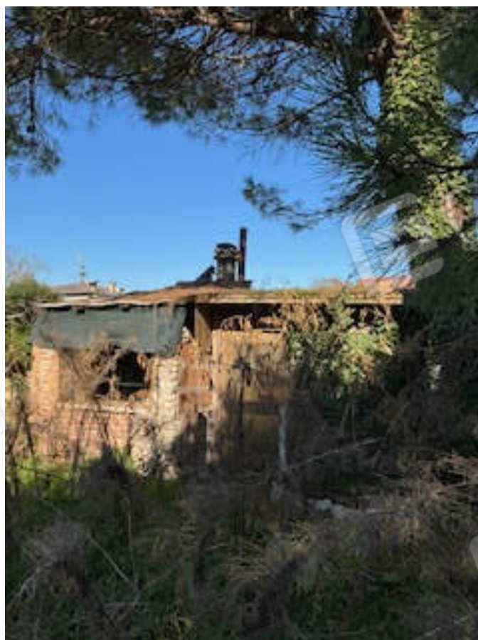
Vista manufatto ad uso barbecue
