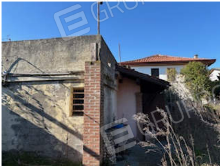
Viste prospetto Est esterno garage sub.6
