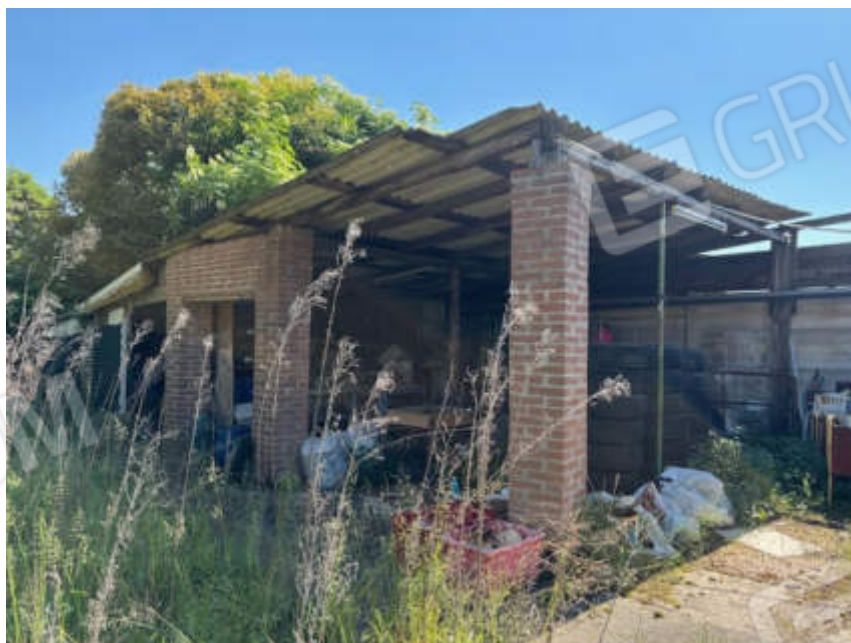
Vista manufatto con struttura mista a uso ricovero attrezzi
