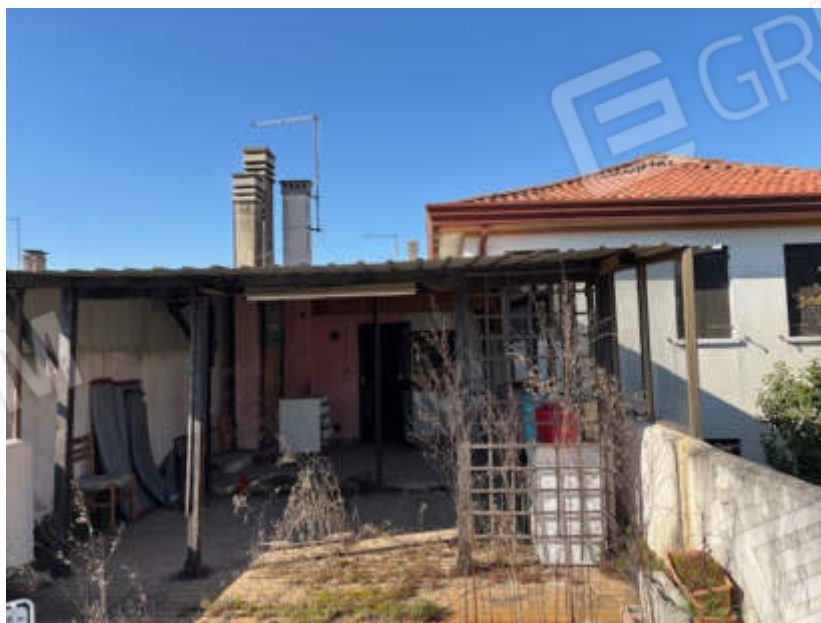
Vista terrazza con tettoia
