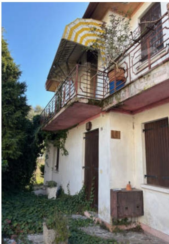
Vista prospetto Est Piano Terra e Primo
