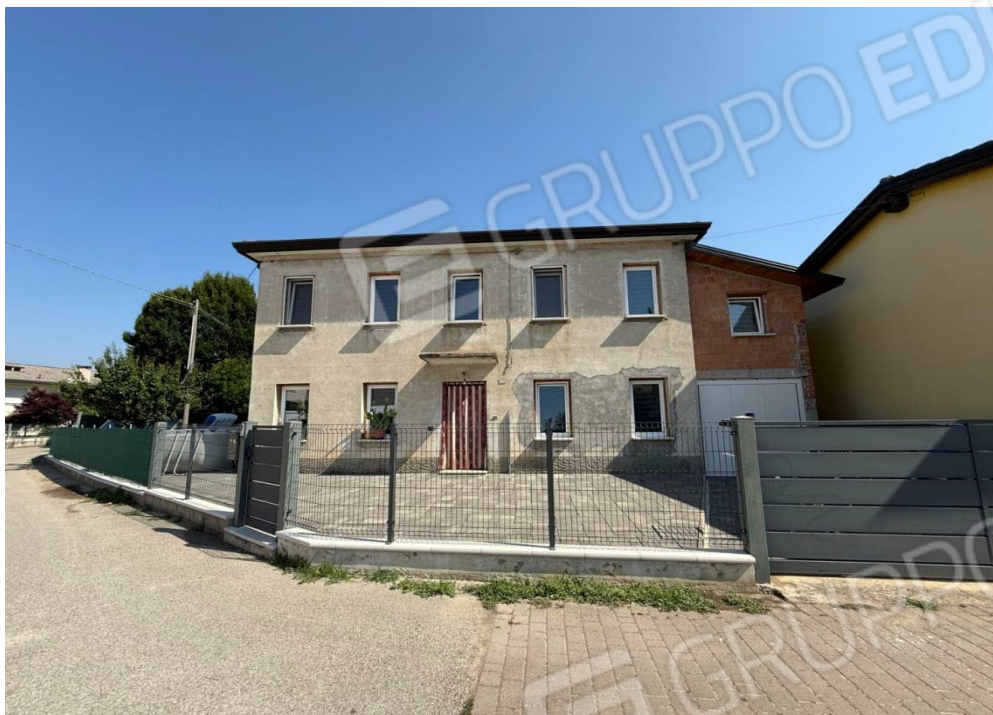
Foto n°1: vista generale da Sud.
