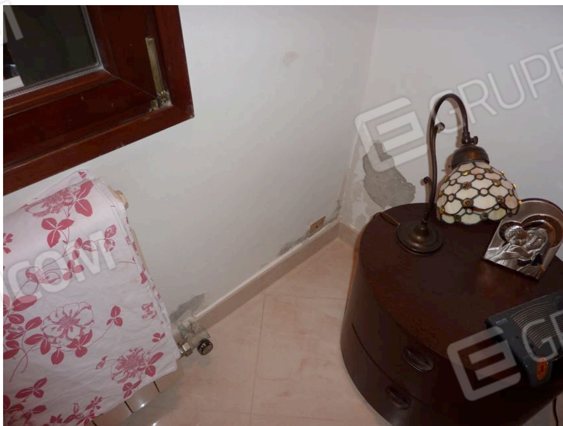
Foto n. 14 Distacchi di stati di pittura angolo nord camera matrimoniale
