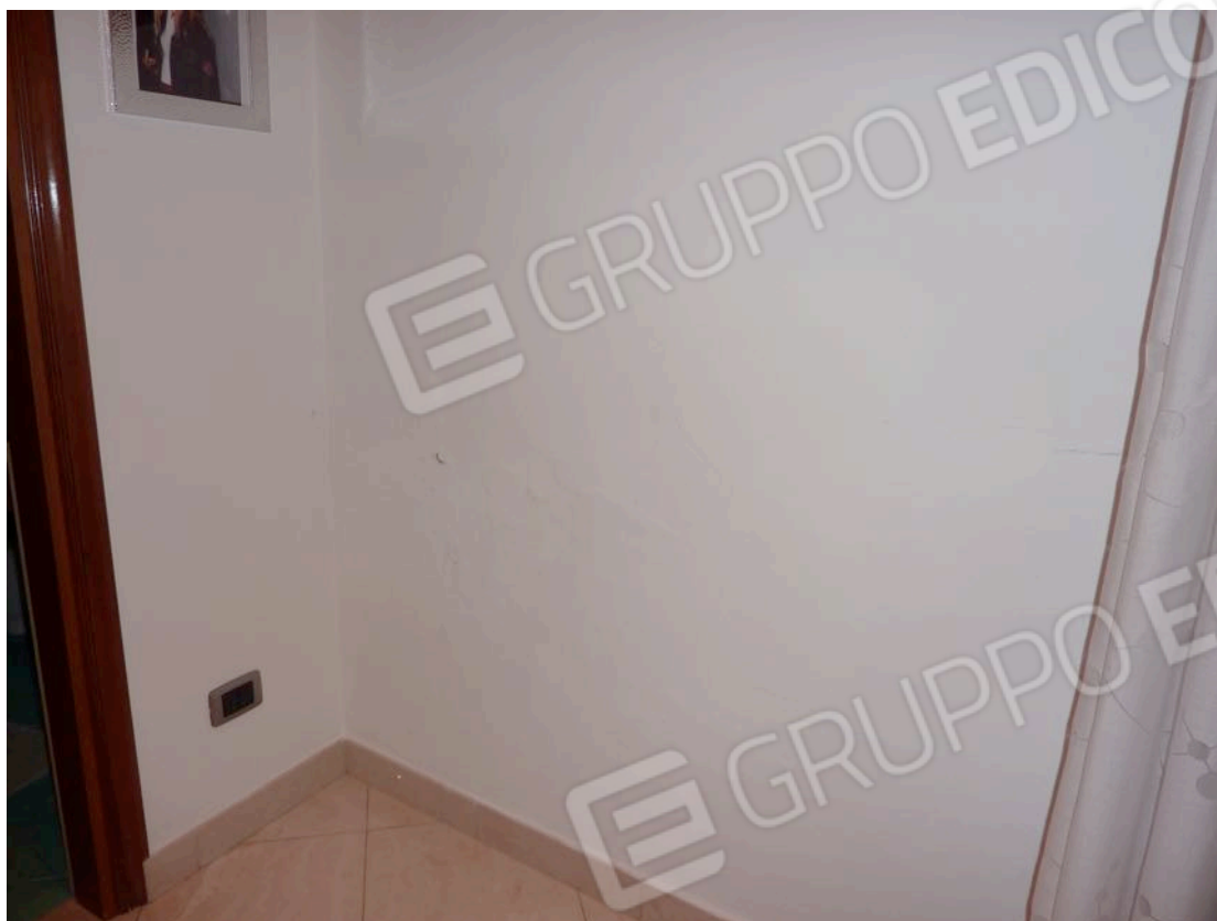
Foto n. 15 Rigonfiamenti di strati di pittura parete sud-est locale disimpegno
