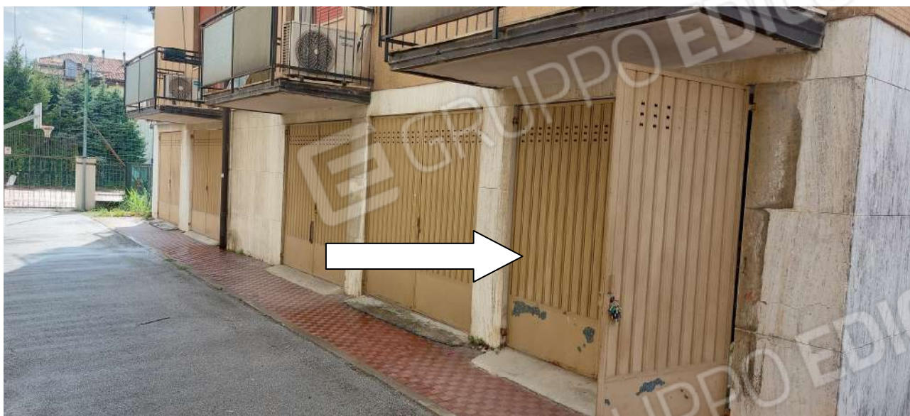
VISTA DEL GARAGE AL PIANO TERRA
