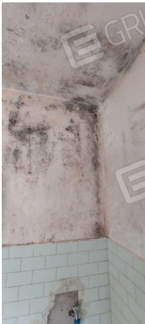
SOFFITTO E PARETE BAGNO
