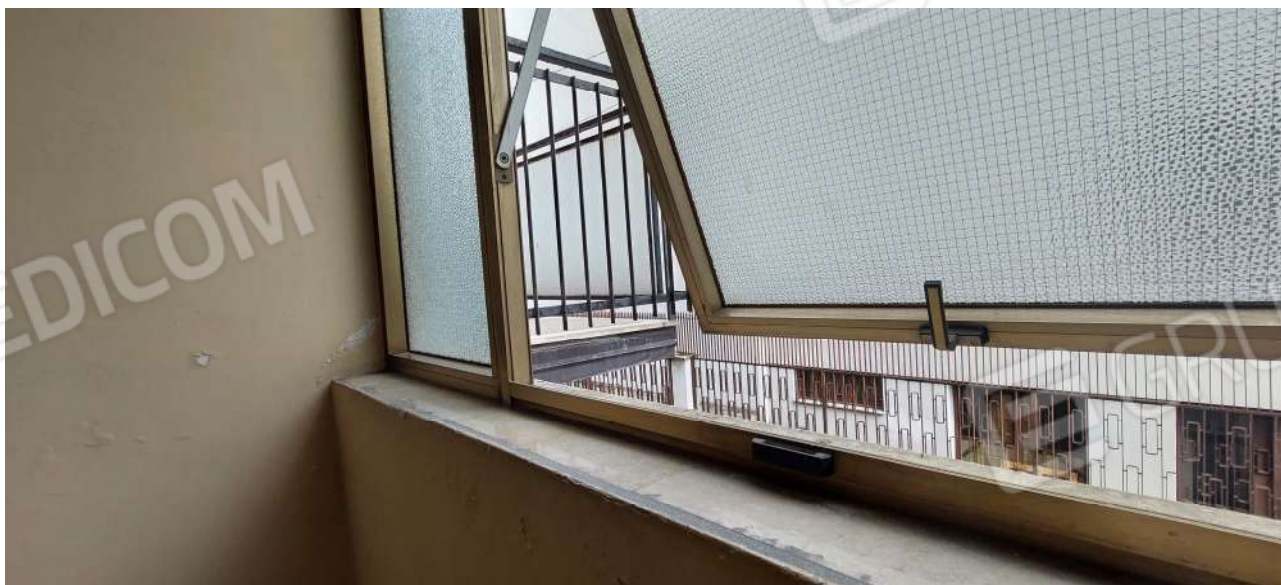
VANO SCALA CONDOMINIALE
