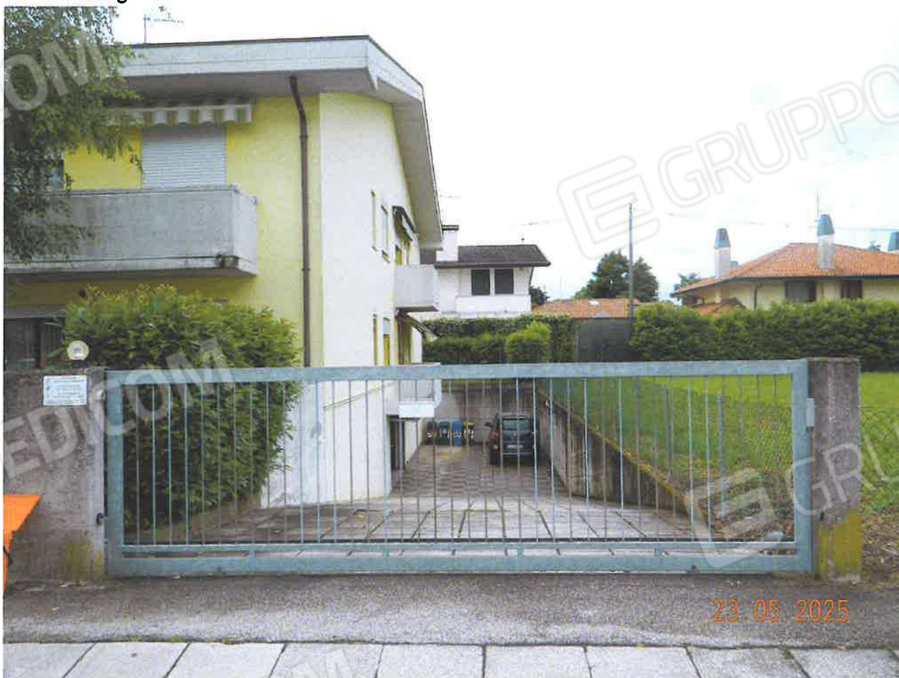
Vista dell'accesso carraio e della rampa da via Guido Galli
